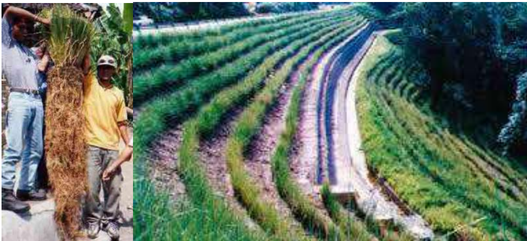
Fotografía 5. Ejemplo de bioingeniería con arbusto (vetiver) en taludes de materiales sueltos.
