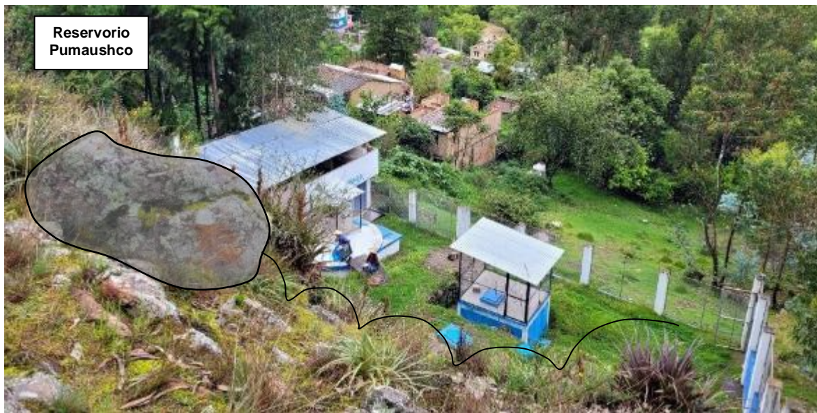
Figura 14. Vista ladera abajo donde se ubica el reservorio de agua y las viviendas afectadas.
