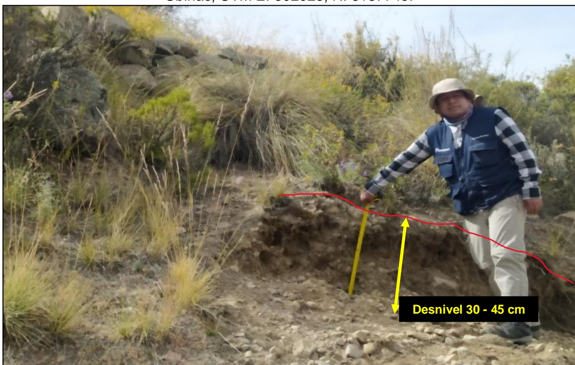
Figura 10. Desnivel de 30 - 45 cm en el deslizamiento reciente DR1, UTM E: 302028, N: 8187745.
