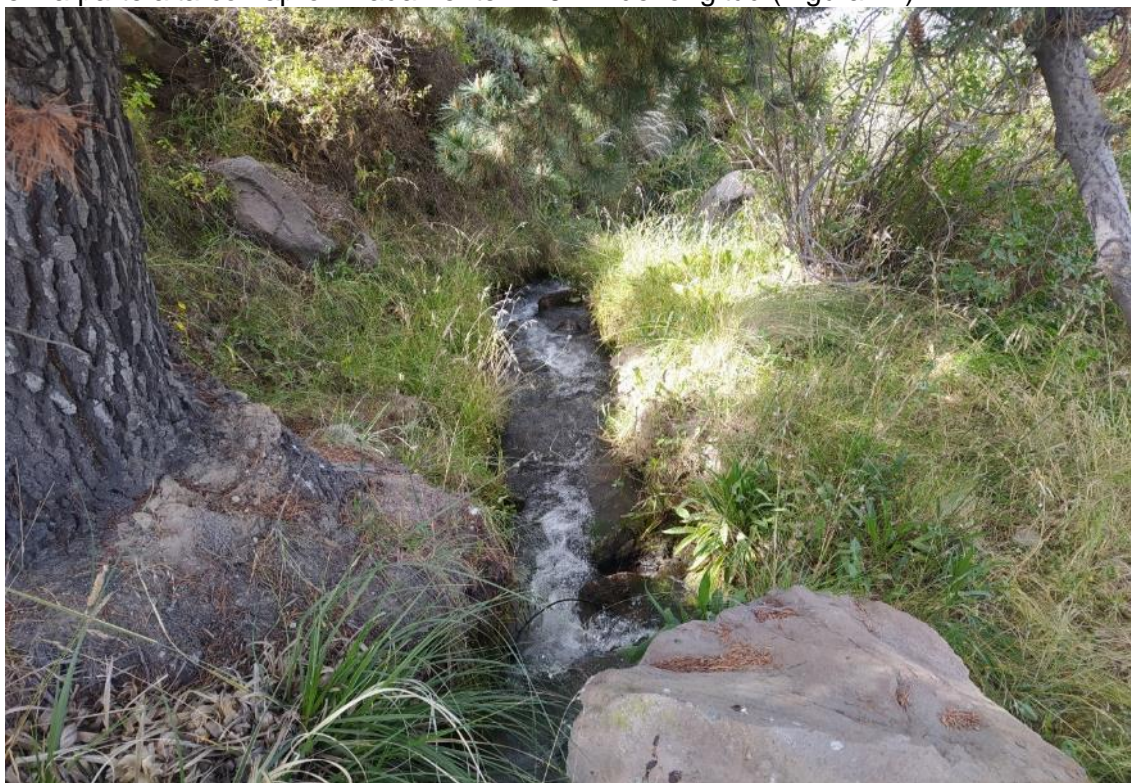
Figura 12. Canal de regadío sin revestimiento en la parte alta del poblado de Ubinas UTM E: 302356, N: 8187059
