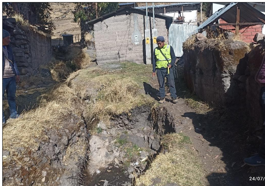
Figura N° 032. Viviendas expuestas al paso del cauce de la Qda Ranrayocc Huaycco
