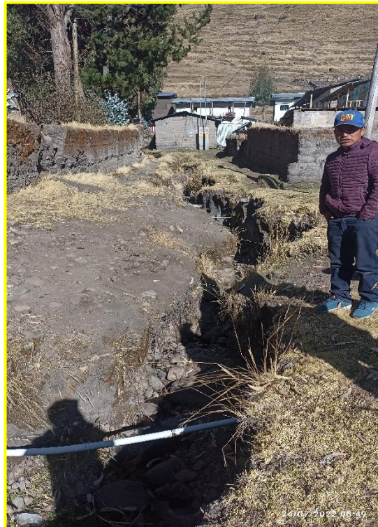
Fotografía N° 11: Vista del paso de la quebrada Ranrayocc Huaycco, se nota una tubería de alimentación de agua para los pobladores de la zona.
