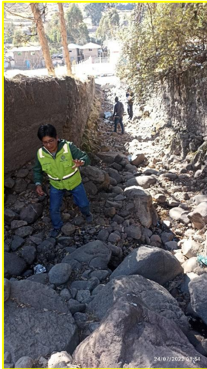
Fotografía N° 13: Vista del cauce de la quebrada Ranrayocco Huaycco, este sector se encuentra en la parte baja, zona poblada.
