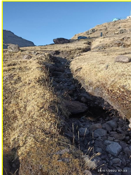
Fotografía N° 01: Vista hacia el oeste del estado del cauce de la quebrada Ranrayocc Huaycco.
