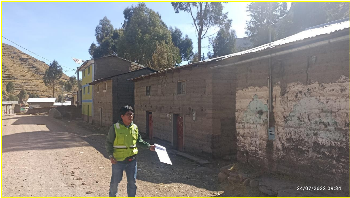
Fotografía N° 20: Vista de viviendas altamente vulnerables, construidas del material rustico.
