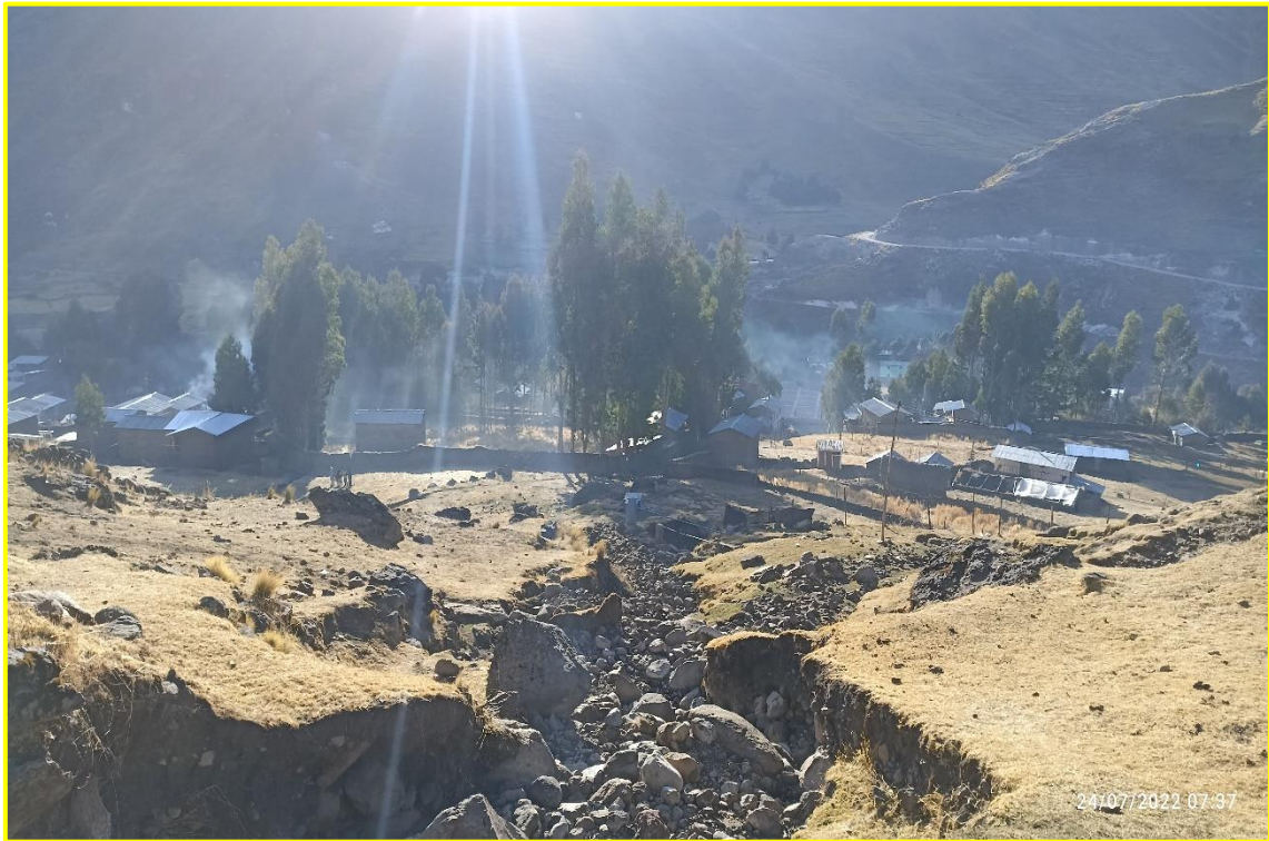
Fotografía N° 03: Vista hacia el este de la quebrada Ranrayocc Huaycco y de fondo el poblado de Chahuarma, nótese en la imagen la gran cantidad de rocas arrastras por el cauce.
