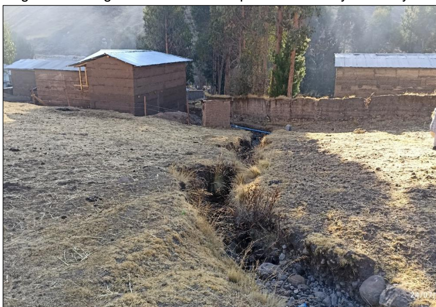
Figura 01. Imagen del cauce de la quebrada Ranrayocc Huaycco.
