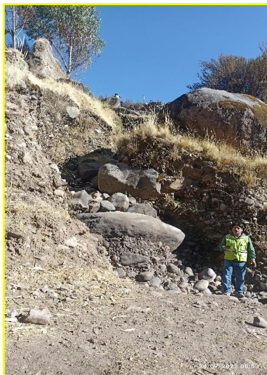
Fotografía N° 1238: Vista hacia el oeste del brusco cambio de nivel del recorrido de la quebrada Ranrayocc Huaycco, este sector esta ubicado dentro de la zona poblada.
