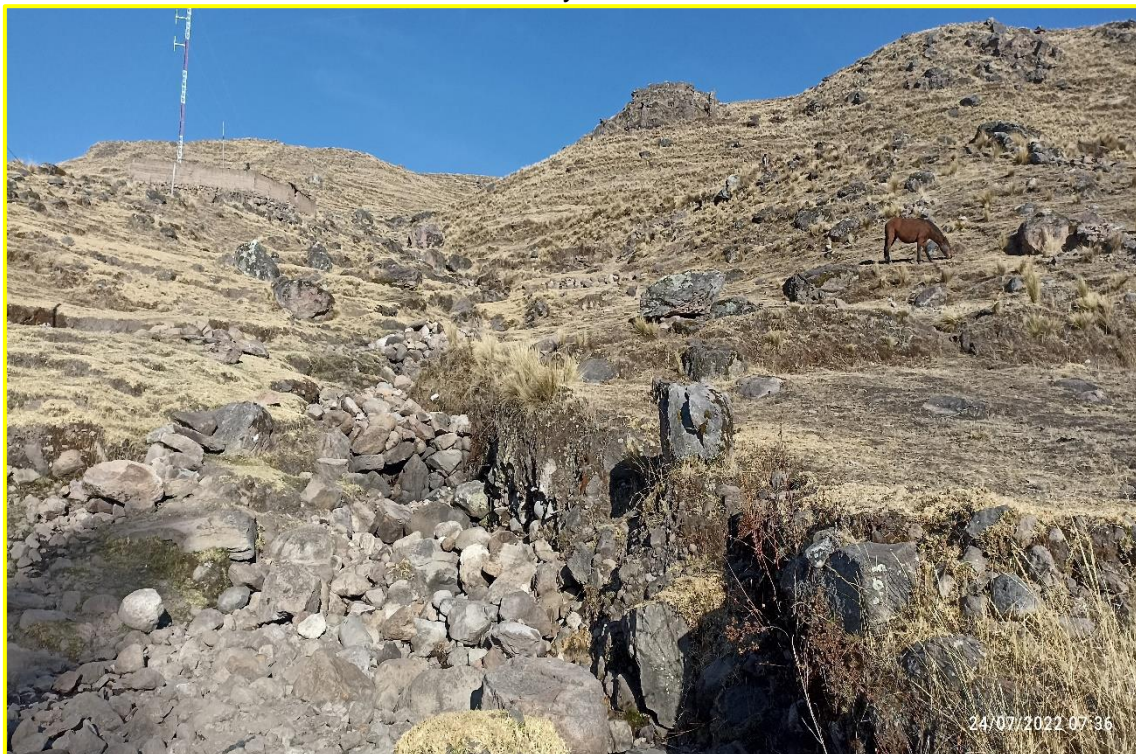
Fotografía N° 02: Vista hacia el oeste de la zona superior del cauce de la quebrada Ranrayocc Huaycco notándose la presencia de grandes rocas.
