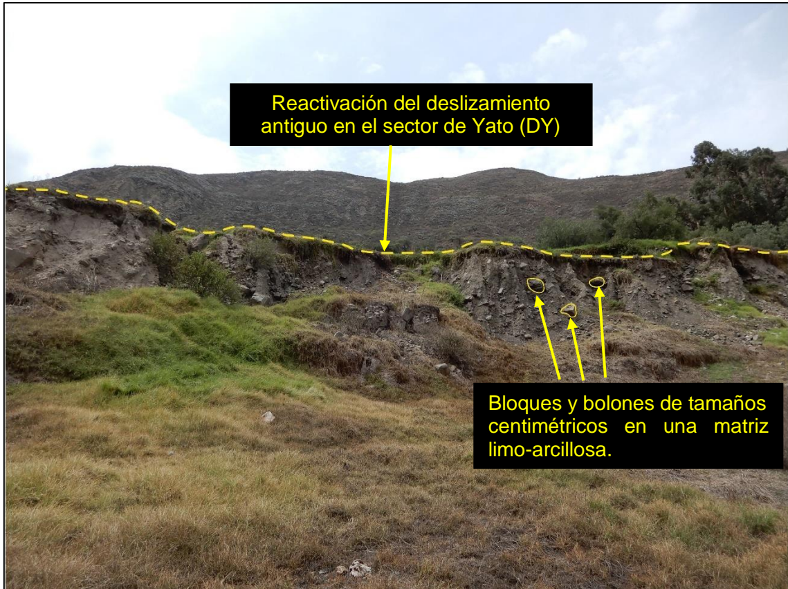
Figura 8. Depósitos del deslizamiento en el sector de Yato (DY). (coordenadas UTM E: 774878, N: 8258511)
