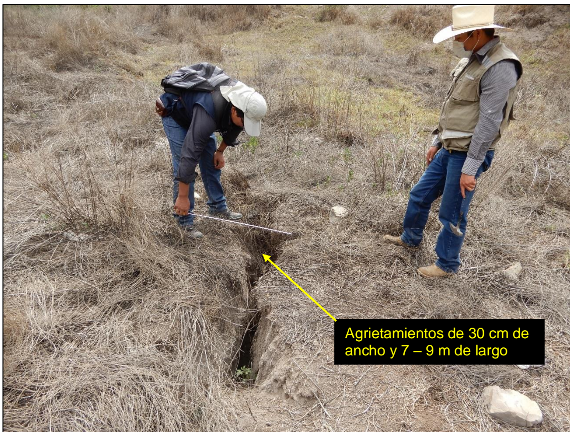
Figura 10. Agrietamientos sobre el cuerpo del deslizamiento reciente (DY). (coordenadas UTM E: 774878, N: 8258511)
