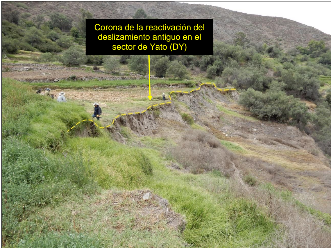
Figura 7. Reactivación del deslizamiento antiguo en el sector Yato. (coordenadas UTM E: 775456, N: 8258978)
