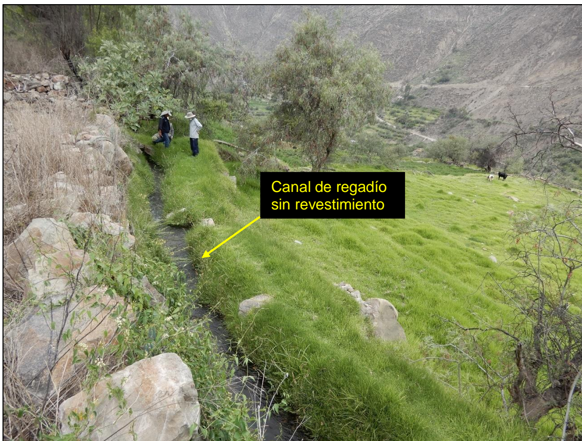
Figura 9. Canal de regadío sin revestimiento encima del deslizamiento en el sector de Yato. (coordenadas UTM E: 774878, N: 8258511)
