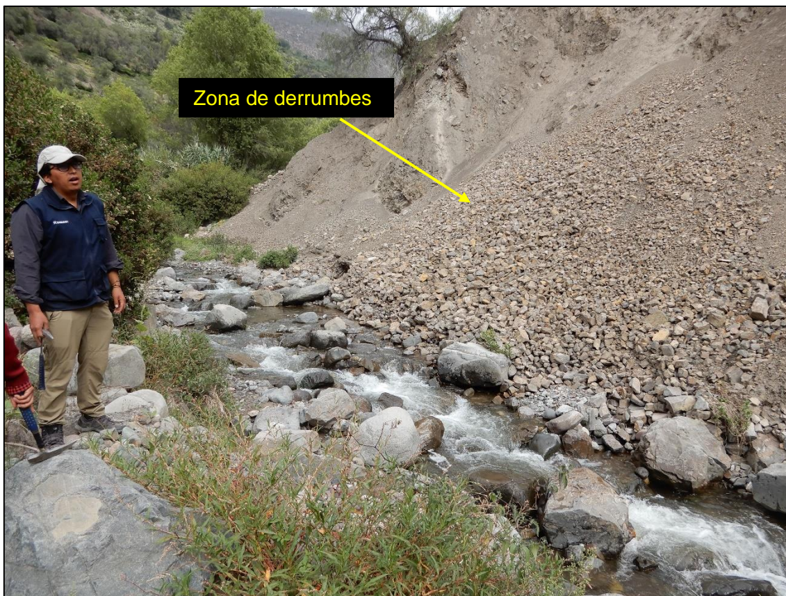
Figura 11. Zona de derrumbes en la parte baja del sector Yato. (coordenadas UTM E: 774909, N: 8258363).
