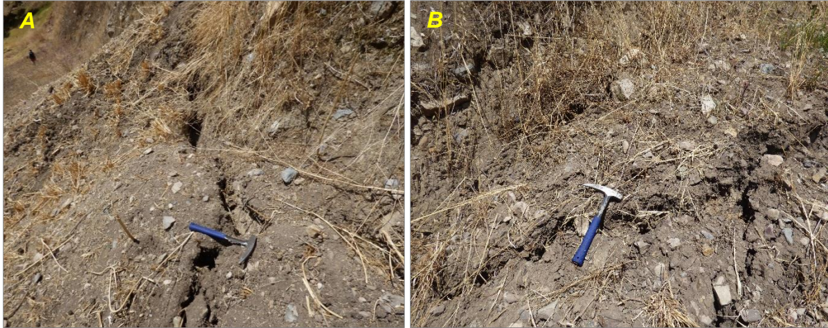
Figura 13. Vista de agrietamientos longitudinales, con apertura de 20 cm y ligero desplazamiento en dirección norte, a lo largo de toda la zona escarpada.
