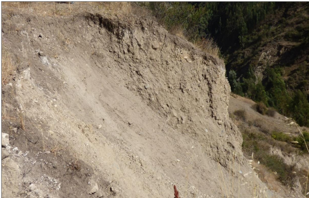
Fotografía 5. Depósito del deslizamiento reactivado, compuesto de material detrítico (bloques, grava, arenas, limo y arcilla), el cual se movilizó, en dirección al río Huachecsa.
