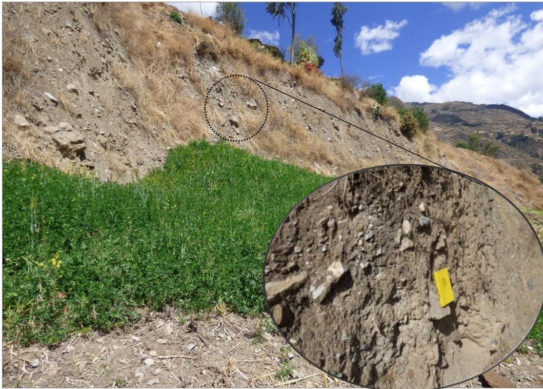
Figura 3. Depósito coluvial-deluvial, compuestos por bloques de calizas angulosas a subangulosas, con diámetro hasta de 1.7 m, gravas y gravillas envueltos en una matriz areno limosa, con regular presencia de arcilla.
