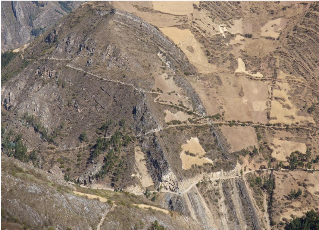
Fotografía 2. Afloramiento rocoso, conformado por areniscas de moderada a altamente meteorizadas y muy fracturadas, condicionadas por la deformación tectónica-estructural.
