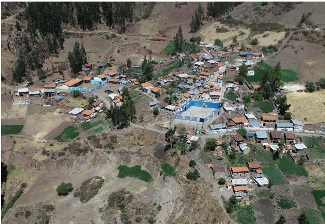
Fotografía 1. Vista de viviendas del centro poblado de Nunupata, ubicadas en el cuerpo de un deslizamiento antiguo.
