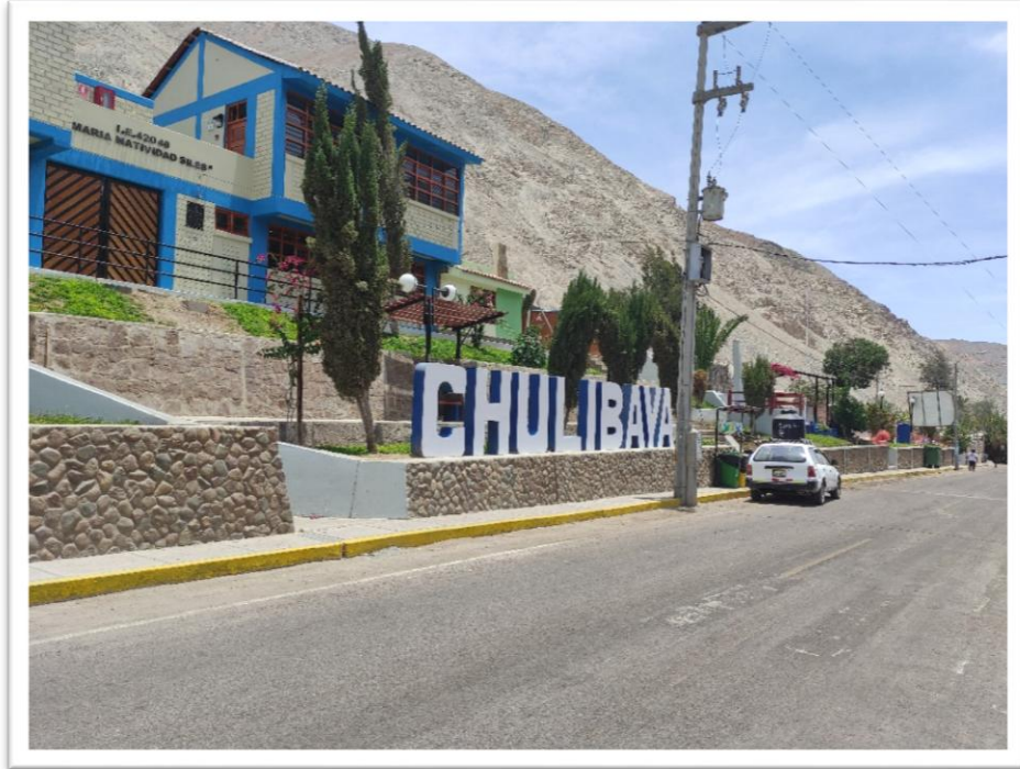
FOTOGRAFÍA 01 ESTUDIO DE EVALUACION DE RIESGOS DE CHULIBAYA (POR FLUJO DE DETRITOS)
