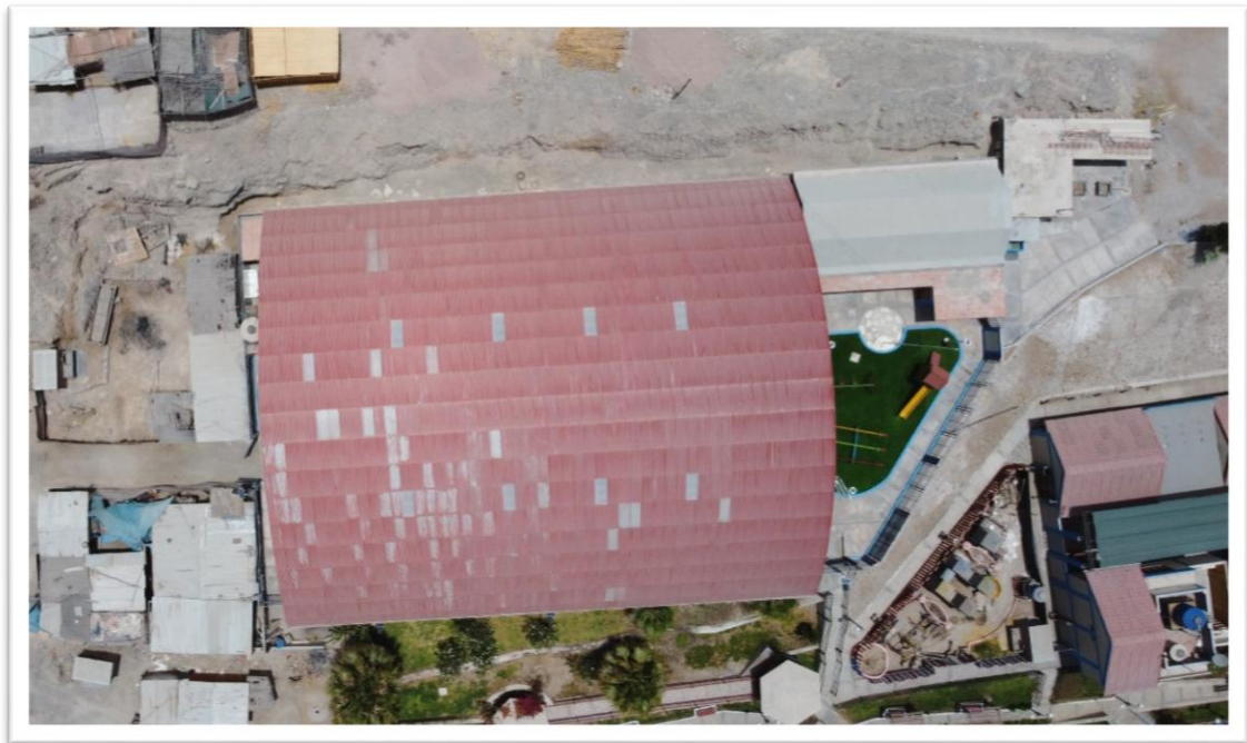
FOTOGRAFÍA 12 FOTO AEREA CON DRONE, LOSA MULTIUSOS DEL CENTRO POBLADO CHULIBAYA.
