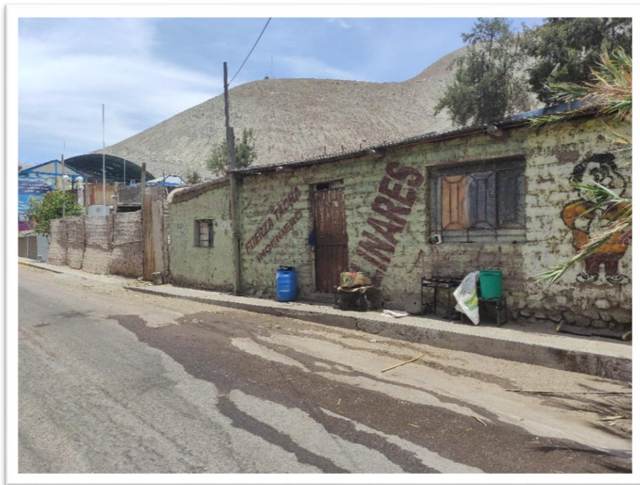
FOTOGRAFÍA 08 RECOLECCIÓN DE INFORMACIÓN POR LOTE (CHULIBAYA). VIVIENDA – MATERIAL EL MATERIAL PREDOMINANTE EN MUROS ES LA MADERA, TECHO DE CALAMINA, ESTADO DE CONSERVACION REGULAR.
