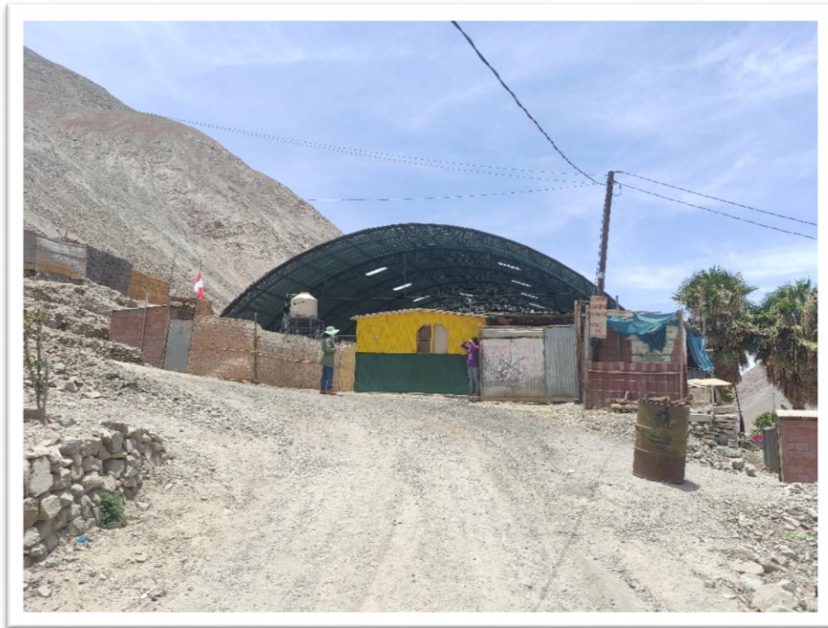
FOTOGRAFÍA 03 RECOLECCIÓN DE INFORMACIÓN POR LOTE (CHULIBAYA), VIVIENDA – MATERIAL PREDOMINANTE EN MUROS MADERA, TECHO DE CALAMINA, ESTADO DE CONSERVACIÓN REGULAR.
