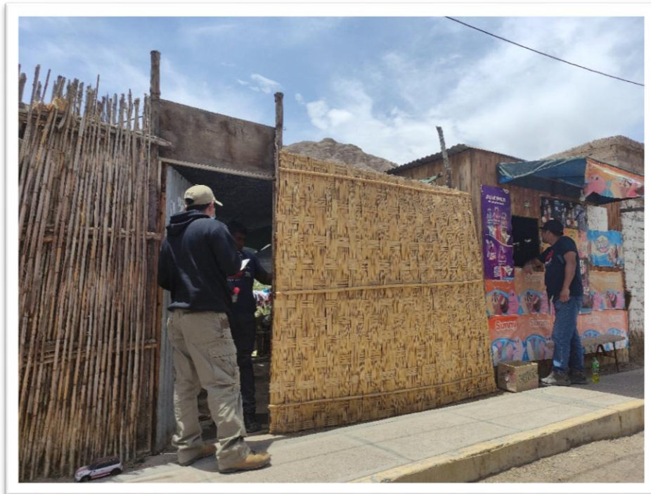
FOTOGRAFÍA 09 RECOLECCIÓN DE INFORMACIÓN POR LOTE (CHULIBAYA). VIVIENDA, MATERIAL PREDOMINANTE EN MUROS ESTERA Y CARRIZO, TECHO DE LONA, ESTADO DE CONSERVACIÓN EN MAL ESTADO.
