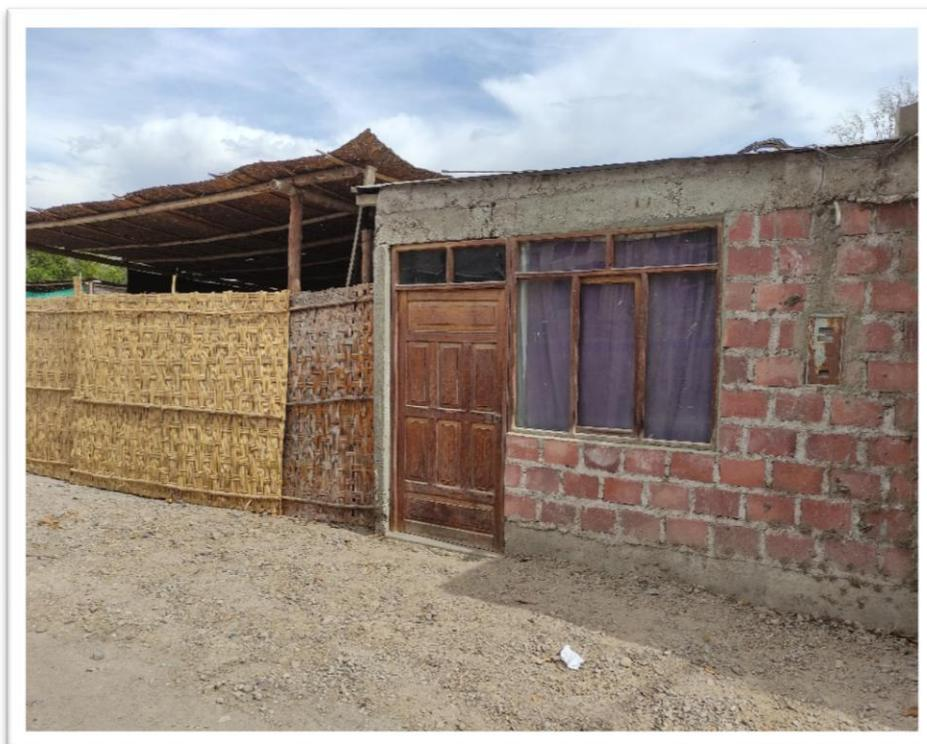
**FOTOGRAFÍA 08:** VIVIENDAS EN MAL ESTADO, E INCLUSO VIVIENDAS IMPROVISADAS DE ESTERAS QUE NO CUMPLEN CON LAS NORMATIVAS CONSTRUCTIVAS SIENDO UN GRAN RIESGO FRENTE A UN PELIGRO POR FLUJO DE DETRITOS.
