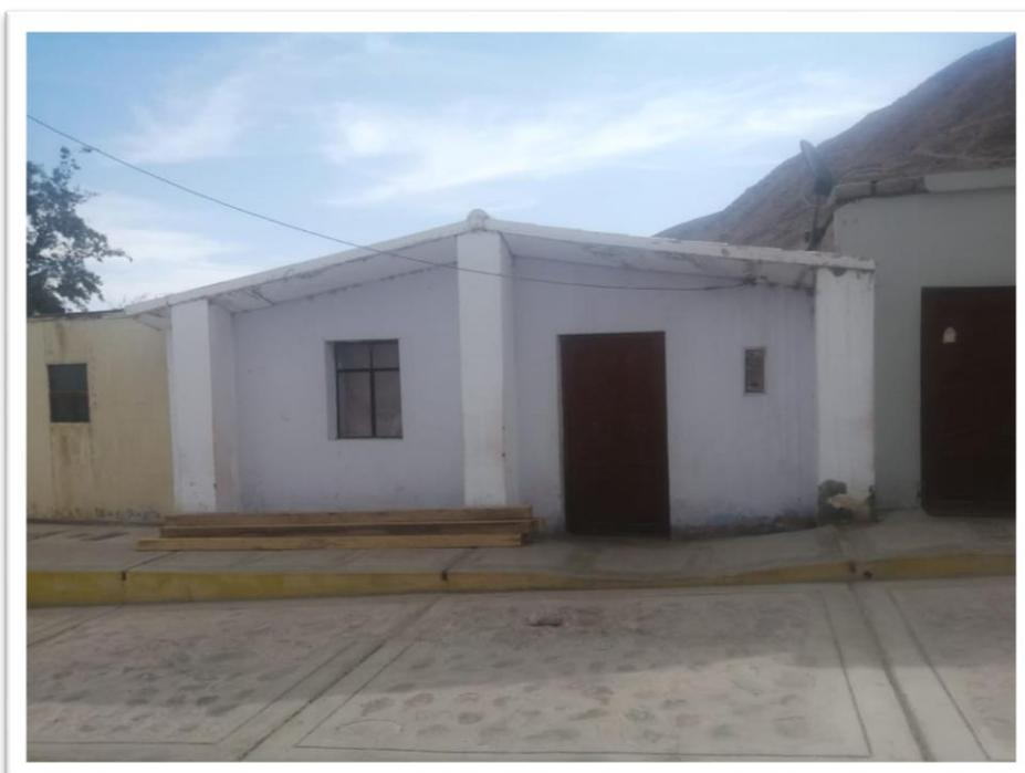
**FOTOGRAFÍA 10 Y 11:** VIVIENDAS EN MAL ESTADO, DE MATERIAL PREDOMINANTE ADOBE CON TECHOS DE CALAMINA, UBICADAS EN DIRECCIÓN DE LA QUEBRADA OCONCHAY.
