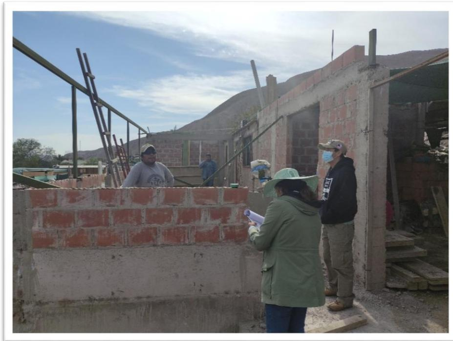
**FOTOGRAFÍA 06:** RECOLECCIÓN DE INFORMACIÓN POR LOTE (OCONCHAY), VIVIENDA – MATERIAL PREDOMINANTE EN MUROS BLOQUETAS DE CONCRETO, TECHO DE CALAMINA, ESTADO DE CONSERVACION REGULAR.
