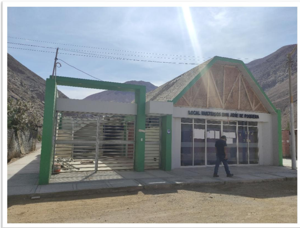
FOTOGRAFÍA 07 LOCAL MULTIUSOS – MATERIAL PREDOMINANTE EN MUROS LADRILLO, TECHO DE ADOBE, ESTADO DE CONSERVACIÓN REGULAR
