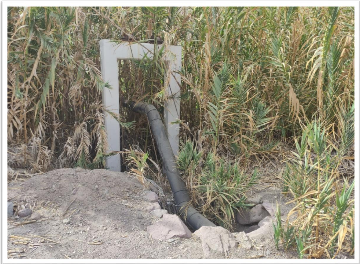
FOTOGRAFÍA 11 ELEMENTOS EXPUESTOS PASE DE AGUA.
