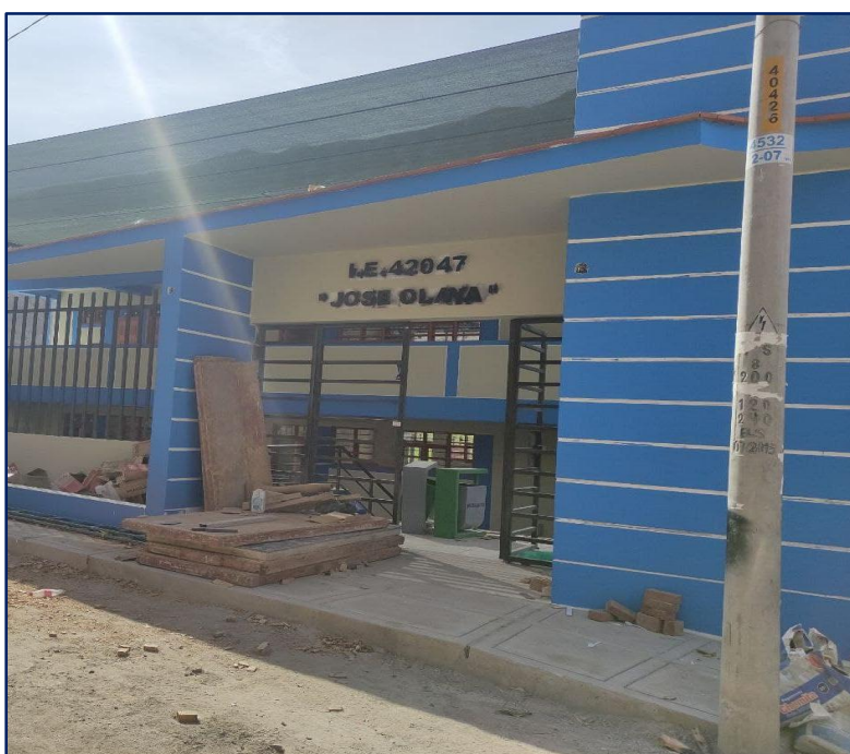
Gráfico N° 9. Se observa la nueva infraestructura de la I.E N° 42047 Jose Olaya
