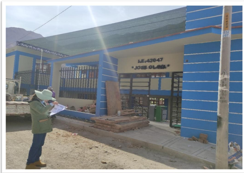
FOTOGRAFÍA 05 IE 42047 JOSE OLAYA, MATERIAL PREDOMINANTE EN MUROS LADRILLO, TECHO DE CONCRETO, ESTADO DE CONSERVACIÓN BUENO.
