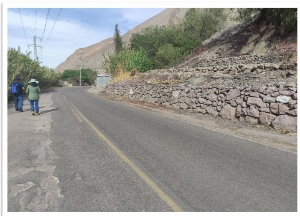
FOTOGRAFÍA 08 RECOLECCIÓN DE INFORMACIÓN (POQUERA) ELEMENTOS EXPUESTOS AL COSTADO DERECHO DE LA VIA, MURO SECO.
