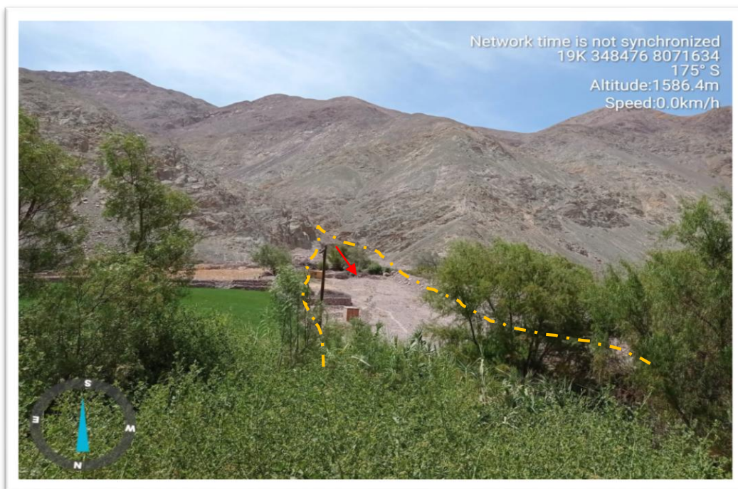
Gráfico N° 45. Vista de detritos aluviales 2, presenta 1.60 m de espesor y yacen en la quebrada estacional ubicada a 2.2 km al este del sector medio del C.P. Poquera, al activarse puede afectar a las casas de campo y áreas agrícolas.
