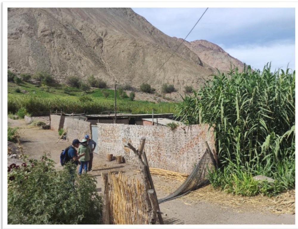
FOTOGRAFÍA 09 RECOLECCIÓN DE INFORMACIÓN POR LOTE (POQUERA). VIVIENDA – MATERIAL EL MATERIAL PREDOMINANTE EN MUROS ES LA MADERA, TECHO DE CALAMINA, ESTADO DE CONSERVACIÓN REGULAR.
