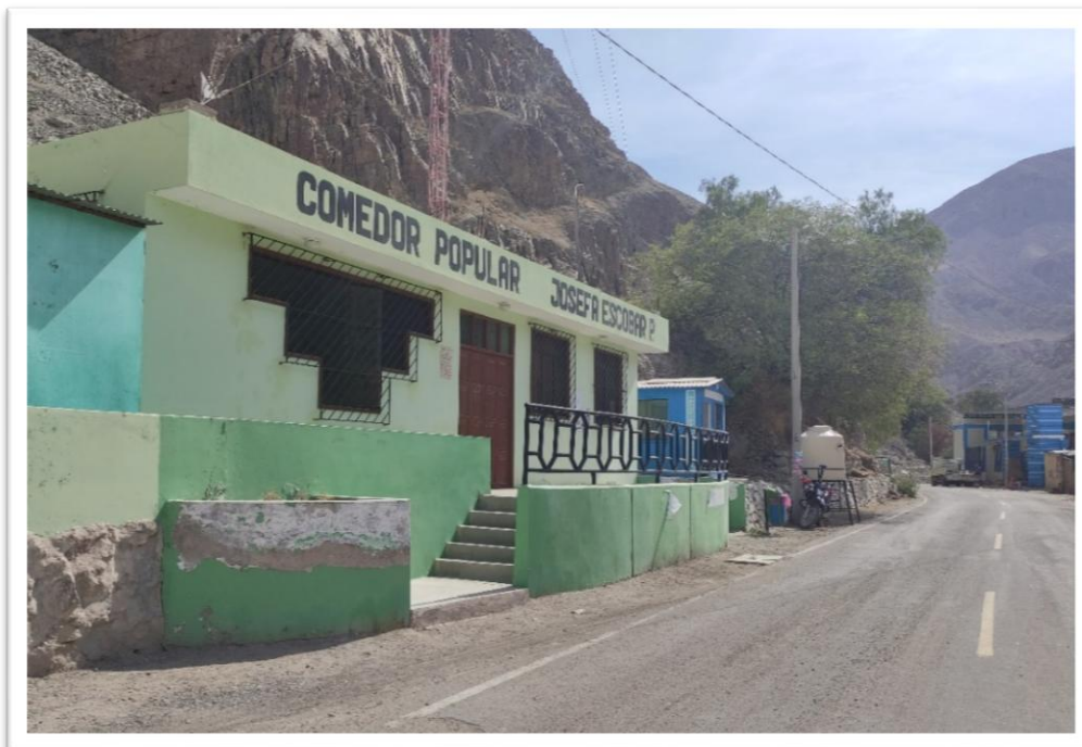
FOTOGRAFÍA 06 COMEDOR POPULAR JOSEFA ESCOBAR DEL CENTRO POBLADO POQUERA, MATERIAL PREDOMINANTE EN MUROS LADRILLO, TECHO DE CONCRETO O LADRILLOS
