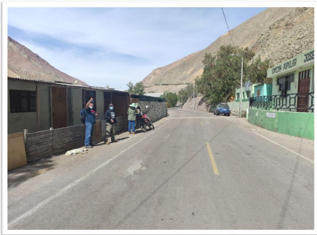
FOTOGRAFÍA 03 RECOLECCIÓN DE INFORMACION POR LOTE (POQUERA), VIVIENDA – MATERIAL PREDOMINANTE EN MUROS MADERA, TECHO DE CALAMINA, ESTADO DE CONSERVACION REGULAR.
