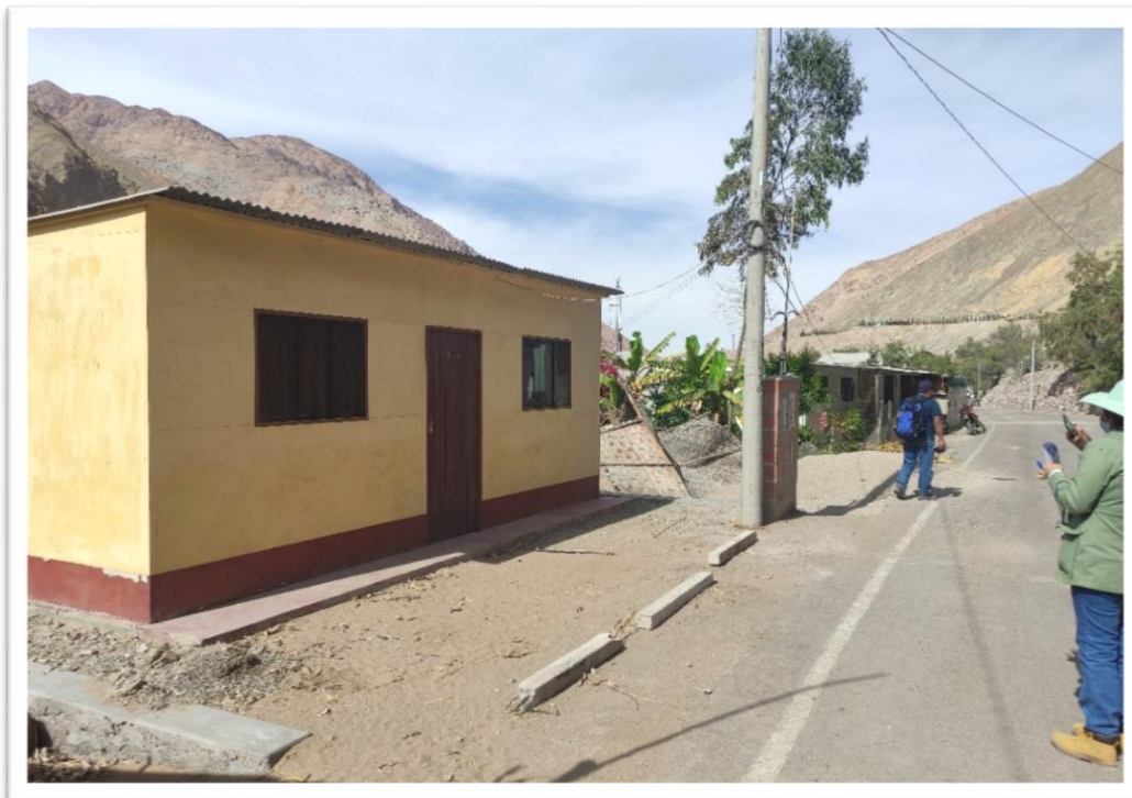
FOTOGRAFÍA 04 VIVIENDA – MATERIAL PREDOMINANTE EN MUROS MADERA, TECHO CALAMINA, ESTADO DE CONSERVACIÓN REGULAR
