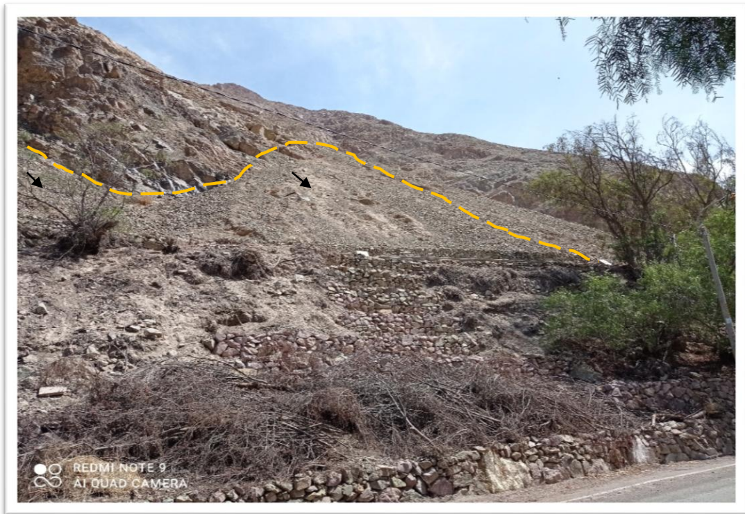
Gráfico N° 40. Vista de detritos del depósito deluvial de ladera de 8 a 10 m de espesor, ubicado frente a la carreta que baja hacia el comedor del C.P. Poquera.
