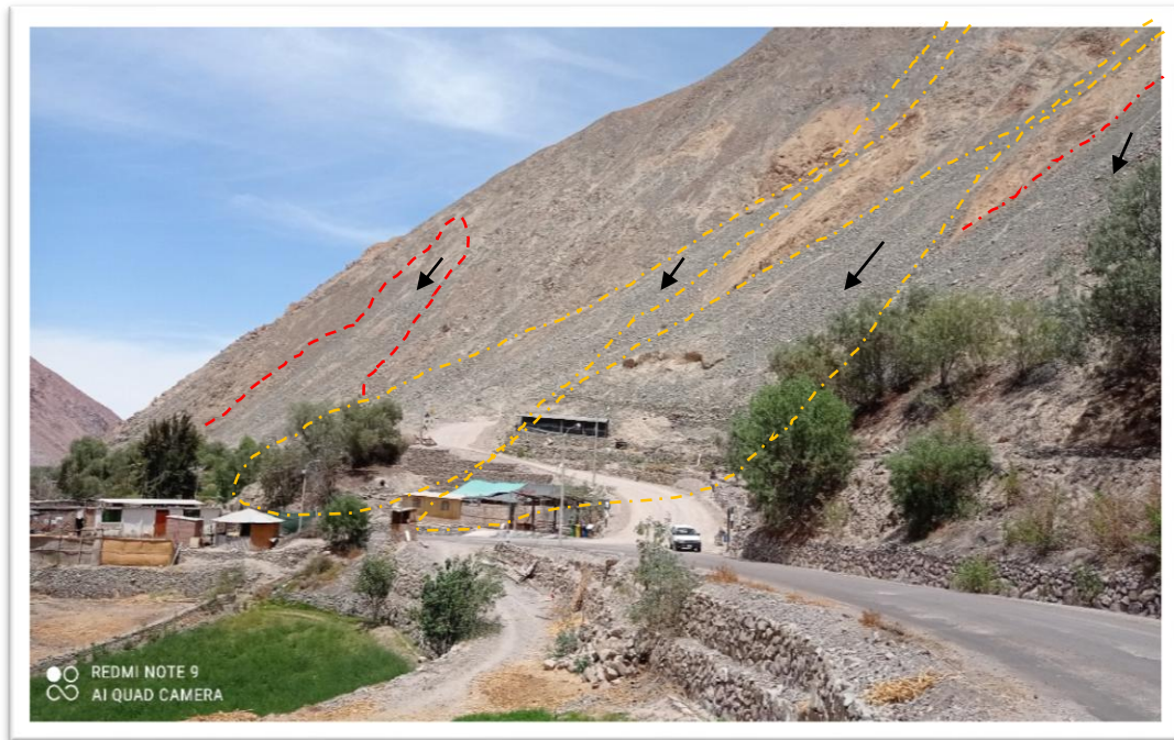
Gráfico N° 44. Vista de detritos deluviales de 8 a 3 m de espesor, susceptibles a flujos de detritos como a derrumbes, ubicados en laderas de montaña a inmediaciones del sector oeste del C.P. Pouera.
