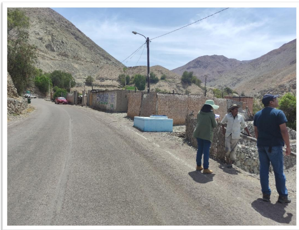
FOTOGRAFÍA 02 RECOLECCIÓN DE INFORMACIÓN POR LOTE (POQUERA), VIVIENDA – MATERIAL PREDOMINANTE EN MUROS ADOBE, TECHO DE CALAMINA, ESTADO DE CONSERVACIÓN REGULAR.
