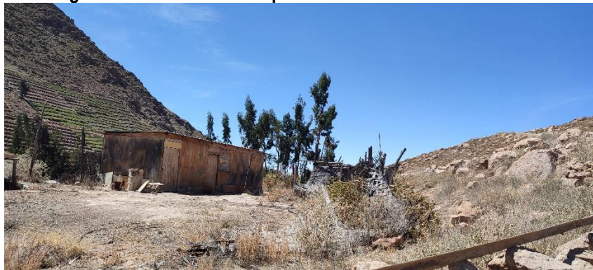
Imagen N°07: Viviendas con paredes de madera machihembrada.
