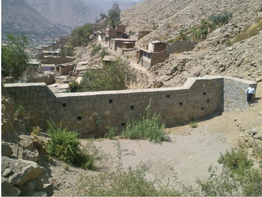
Imagen N°35 – Dique de concreto y roca
