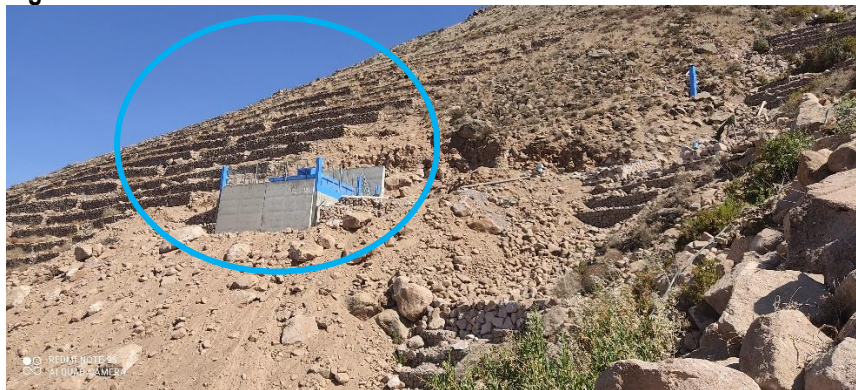
Imagen N°11: Reservorio de almacenamiento de concreto 2 – en construcción.
