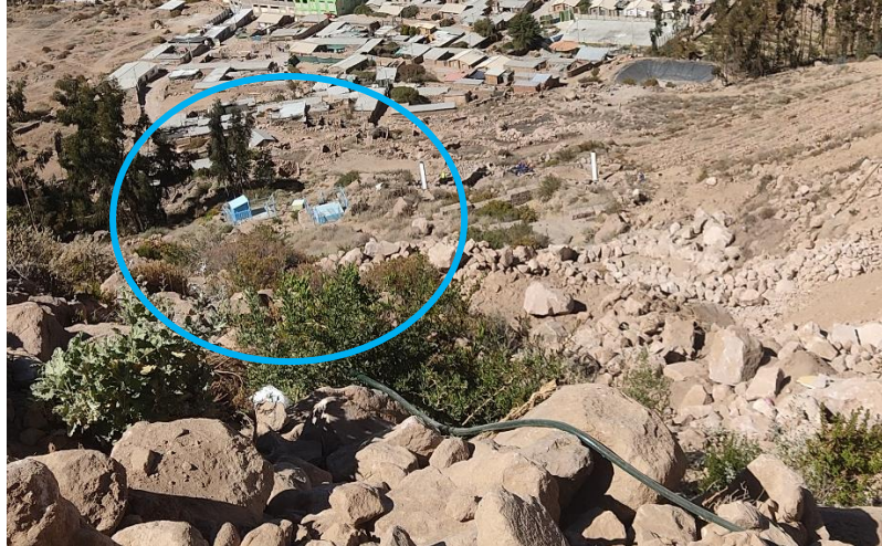
Imagen N°10: Reservorio de almacenamiento de concreto 1- en uso.
