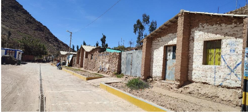
Imagen N°05: Viviendas con paredes de adobe.
