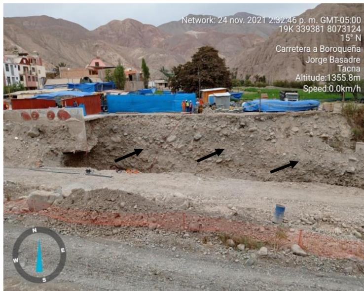
**Figura 21.** Vista de erosión fluvial debido a la fuerza erosiva del río Calumbraya que desciende de noroeste a sureste por la parte sur del C.P. Ilabaya.
