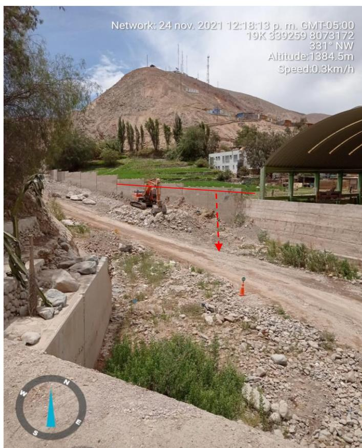
**Figura 20.** Vista de sedimentación aluvial de más de 3 m de altura que supero la defensa ribereña y sedimento el coliseo del C.P. Ilabaya en el año 2019.
