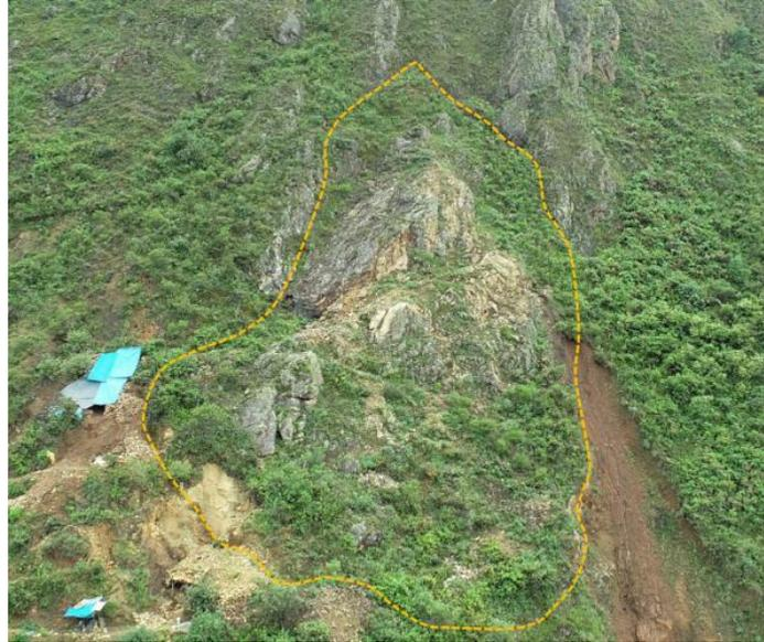
**Figura 6.** Vista frontal del deslizamiento de 58 m de longitud horizontal del eje principal y 35 m de ancho en el pie, ubicado en el cerro San Francisco. Coordenadas UTM: 213504.58 / 9138474.26, zona 18.
