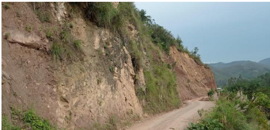
Figura 4. Macizo rocoso muy fracturado y altamente meteorizado de la Formación Sarayaquillo en la vía Pipus – Cheto. Ubicación: Este: 197802, Norte: 9310213; Altitud: 2031. Fuente: Municipalidad Provincial de Chachapoyas.
