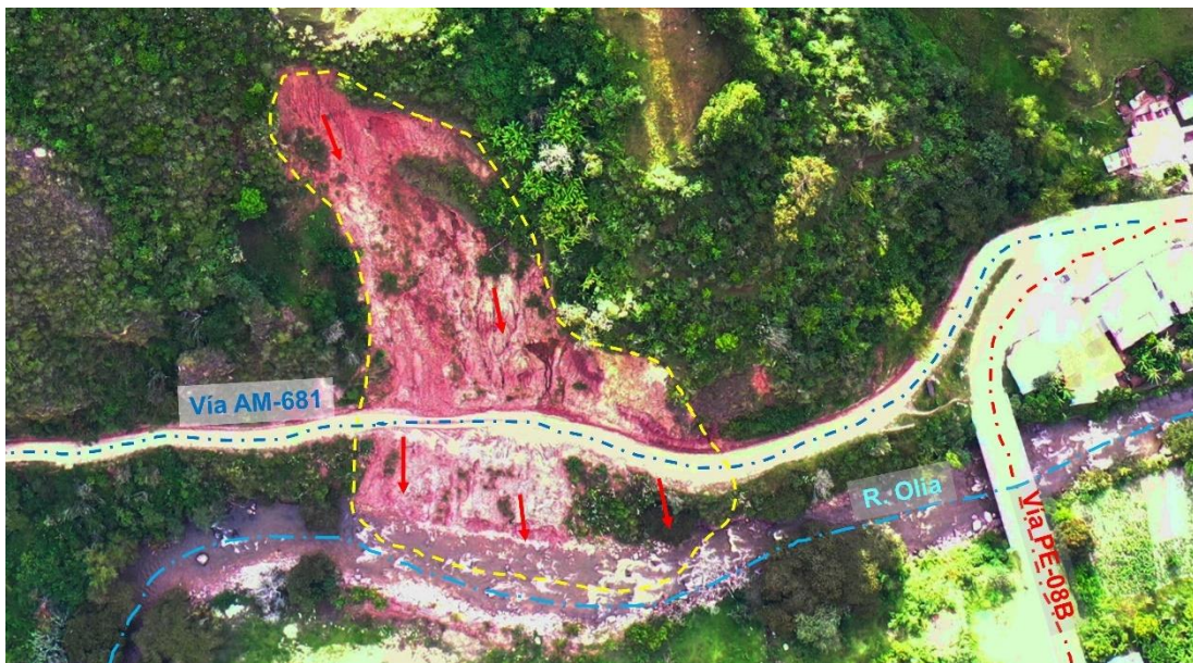
Figura 21. Vista del deslizamiento sobre la vía AM-681, en la localidad de Pipus. Ubicación: Este: 197625; Norte: 9310517; Altitud: 2018.
