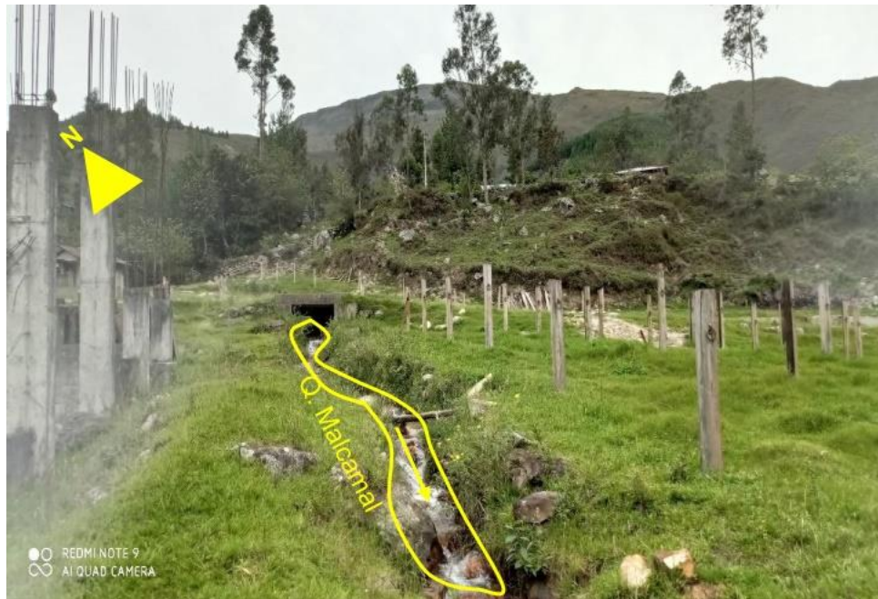
Figura 16. Vista actual del cauce de la quebrada Malcamal sin canalización adecuada. Fuente: Municipalidad Provincial de Chachapoyas.
