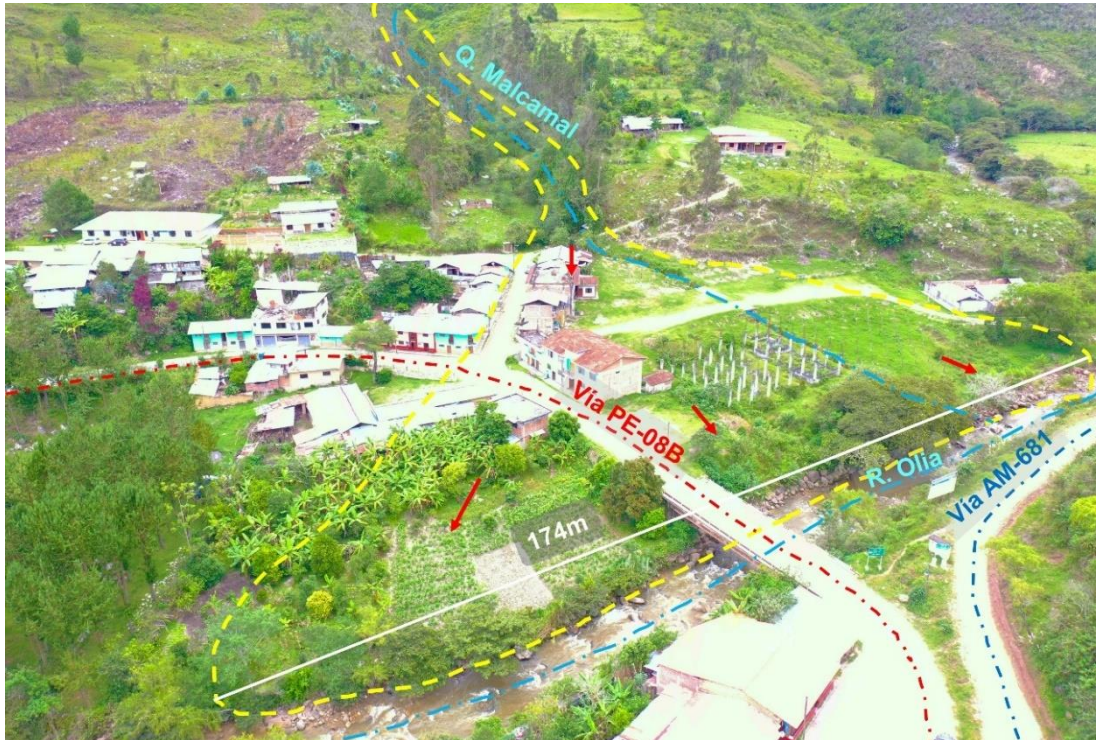
Figura 15. Vista desde un dron del abanico proluvial del flujo de detritos de la quebrada Malcamal, sobre la que se han edificado viviendas, establecidos terrenos agrícolas y vías de comunicación.
