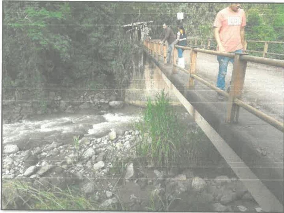
*Foto N° 23: Afectación de las bases del puente*
