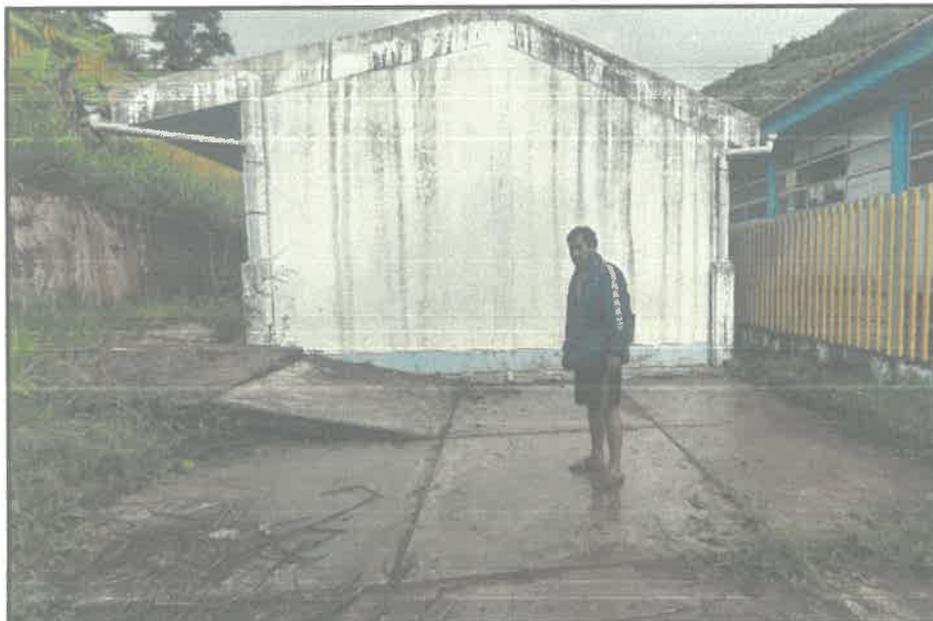
Foto N° 20: Piso levantado y muros de contención fisurados
