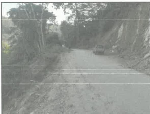
Foto N° 14: Debilitamiento de la plataforma de la vía de acceso
