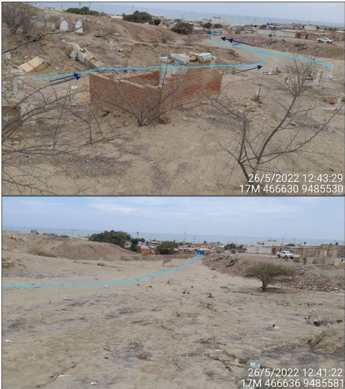
Figura 13.- Quebrada San Vicente, se aprecia su recorrido desde el cementerio antiguo (imagen superior) y continúa hasta la prolongación de la calle Alfonso Ugarte (imagen inferior) donde se han implementado diques precarios conformados con materiales antrópicos (rellenos) como defensas ribereñas
