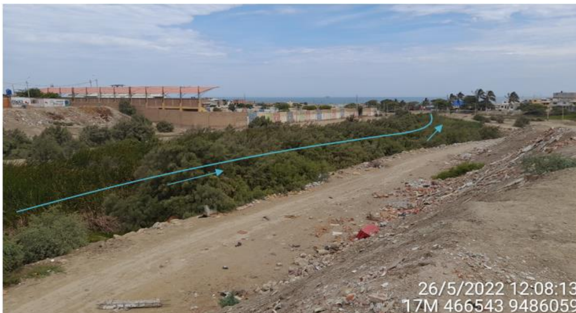
Figura 14.- Cauce de la quebrada Micaela Bastidas que concentra las aguas pluviales del sector San Vicente y de las lagunas de oxidación afectando la vía Prol. Grau
