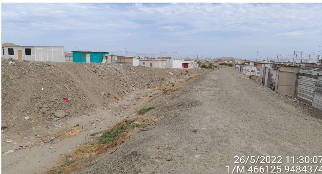
Figura 15.- Cauce de la quebrada ubicada al sur del cementerio que viene siendo colmatada por materiales de relleno (desmonte) para el emplazamiento de viviendas en ambos márgenes, sin embargo, su activación podría generar inundaciones fluviales debido a la precariedad de los diques conformados
