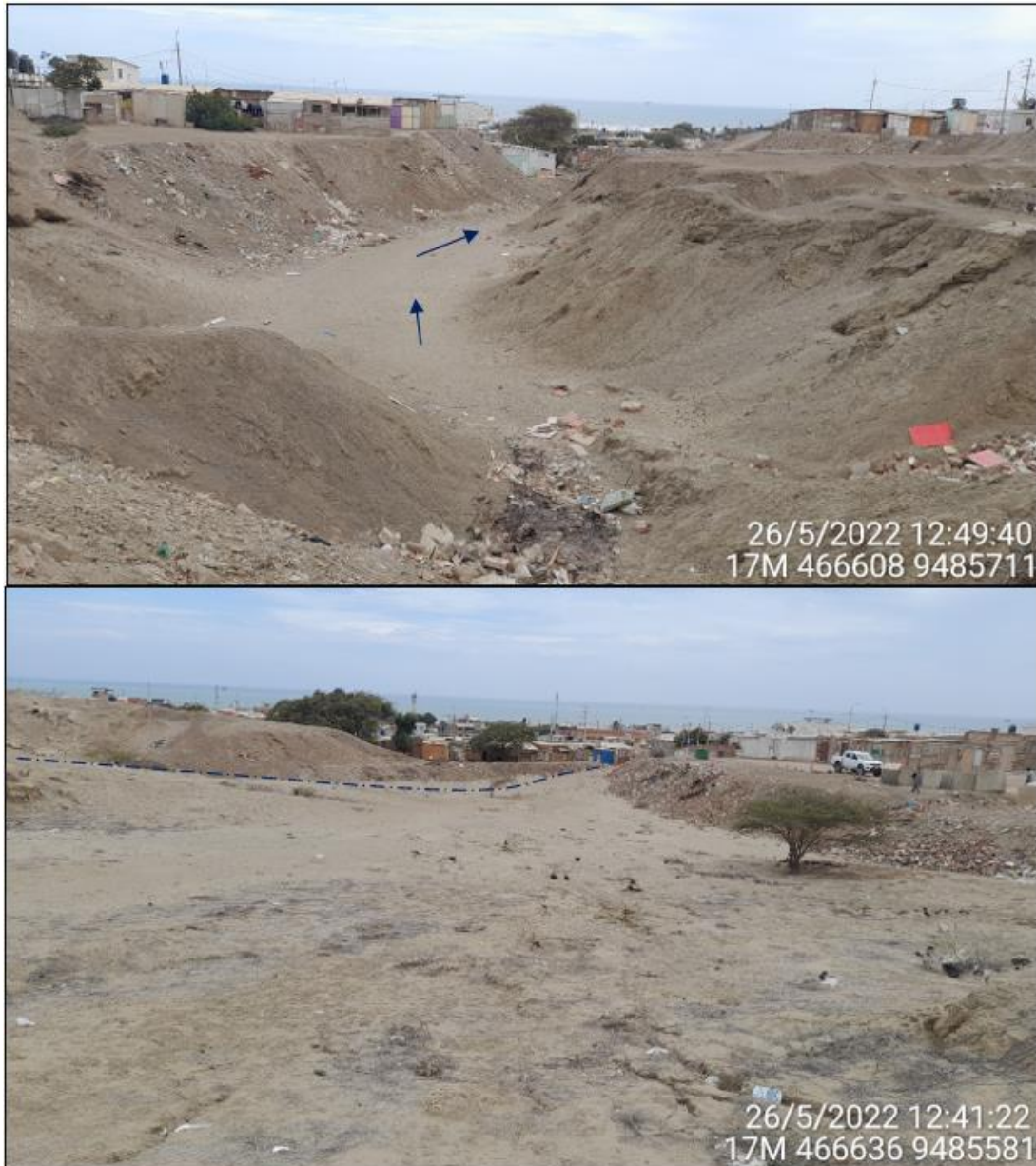
Figura 5.- Cauce de la quebrada San Vicente con la presencia de diques conformados con materiales de relleno antrópico en ambas márgenes y contiguo a viviendas
