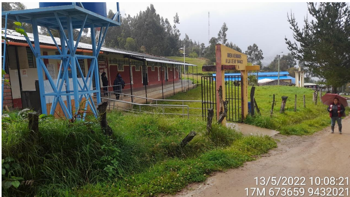
Figura 8.- Loma ubicada en la parte posterior de capilla del caserío Pulun, se aprecia desnivel topográfico superior a los 3 m.
