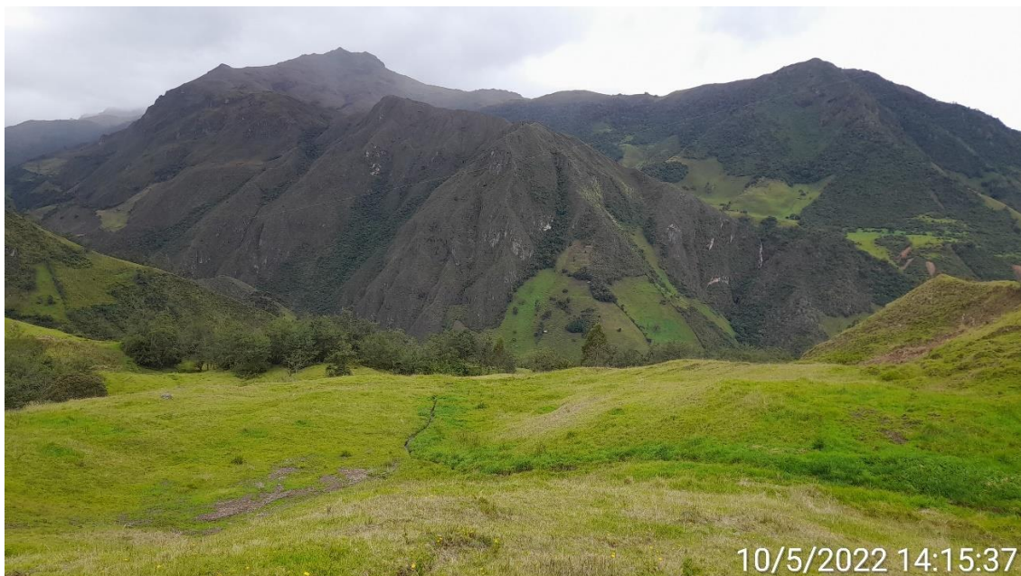
Figura 32.- Ladera susceptible a reptación de suelos debido a la saturación de los suelos durante la ocurrencia de precipitaciones intensas
