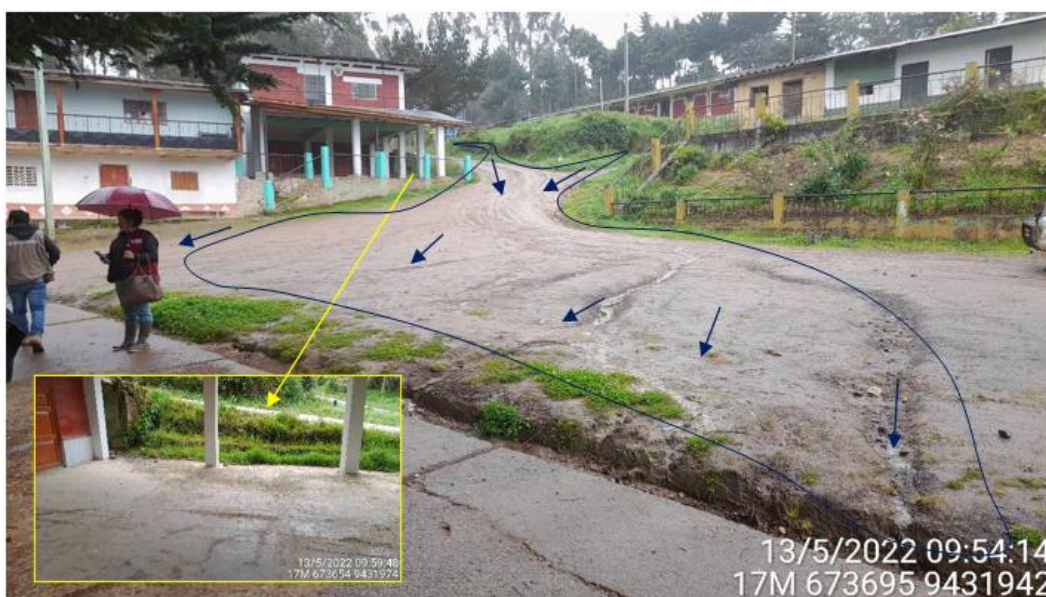
Figura 27.- Escorrentías superficiales generadas en épocas de precipitación que se desplazan por efecto de la inclinación del terreno con dirección a la plaza del caserío Pulun, entre la infraestructura afectada se reconoció la casa de rondas debido a que se encuentra en zona de depresión y el techo no cuenta con canaletas de drenaje
