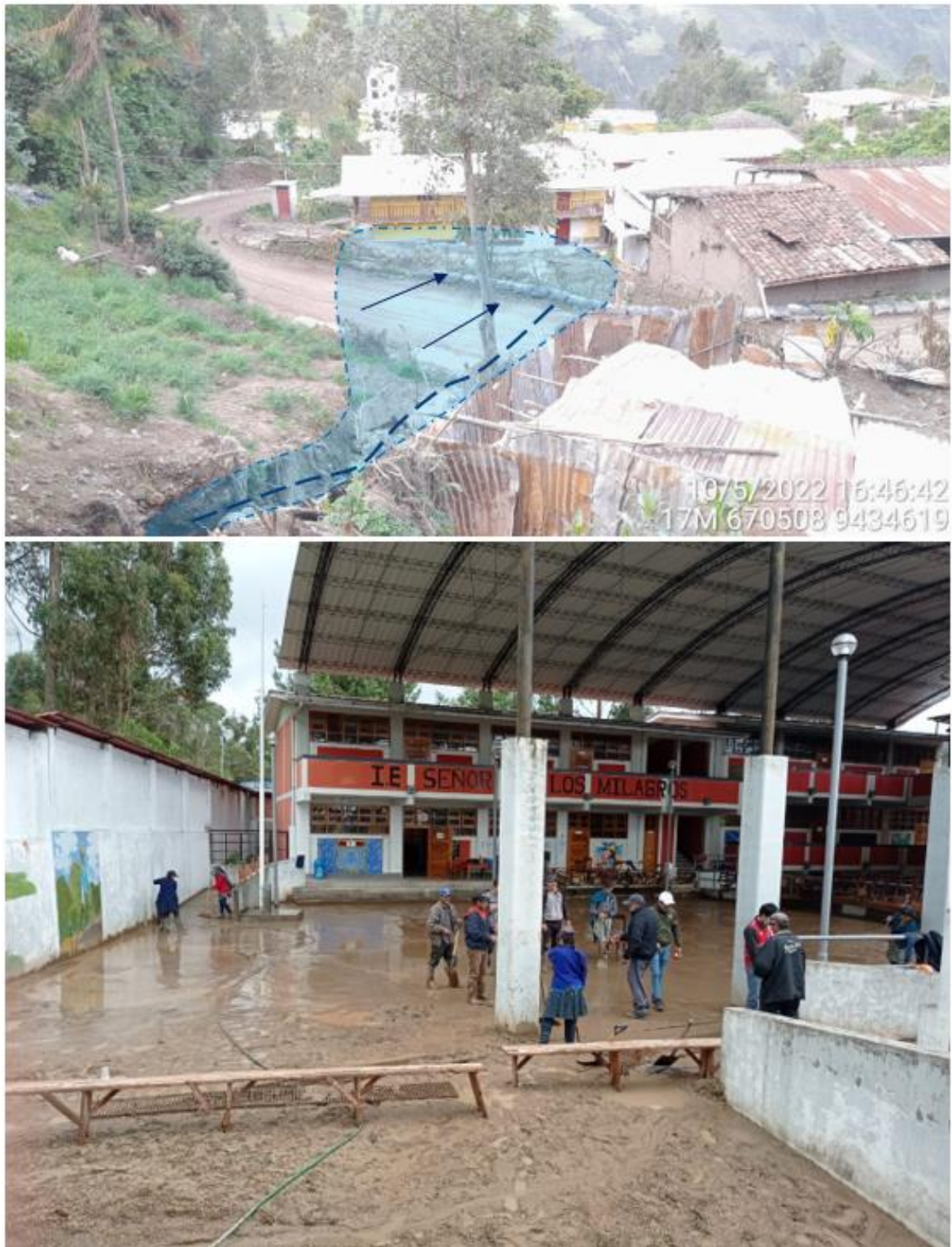
Figura 30.- La imagen superior muestra la dirección del flujo aguas abajo que afecta 3 viviendas y la institución educativa Señor de Los Milagros (imagen inferior)
