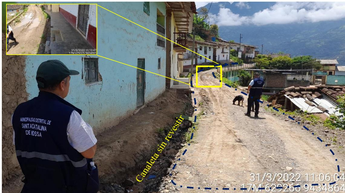
Figura 13.- Áreas susceptibles a inundaciones pluviales (polígono amarillo) en la calle Gaspar Reátegui debido a la falta de sistemas de drenaje pluvial
