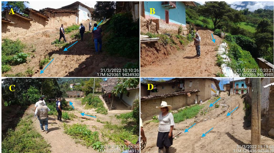
*Figura 12.- Eventos de erosión de laderas que han originado cárcavas (flechas celestes) en las calles Prolongación Comercio (A), Palmeras (B), Calle 6 (C) y Cajamarca (D) durante la ocurrencia de precipitaciones pluviales intensas.*
