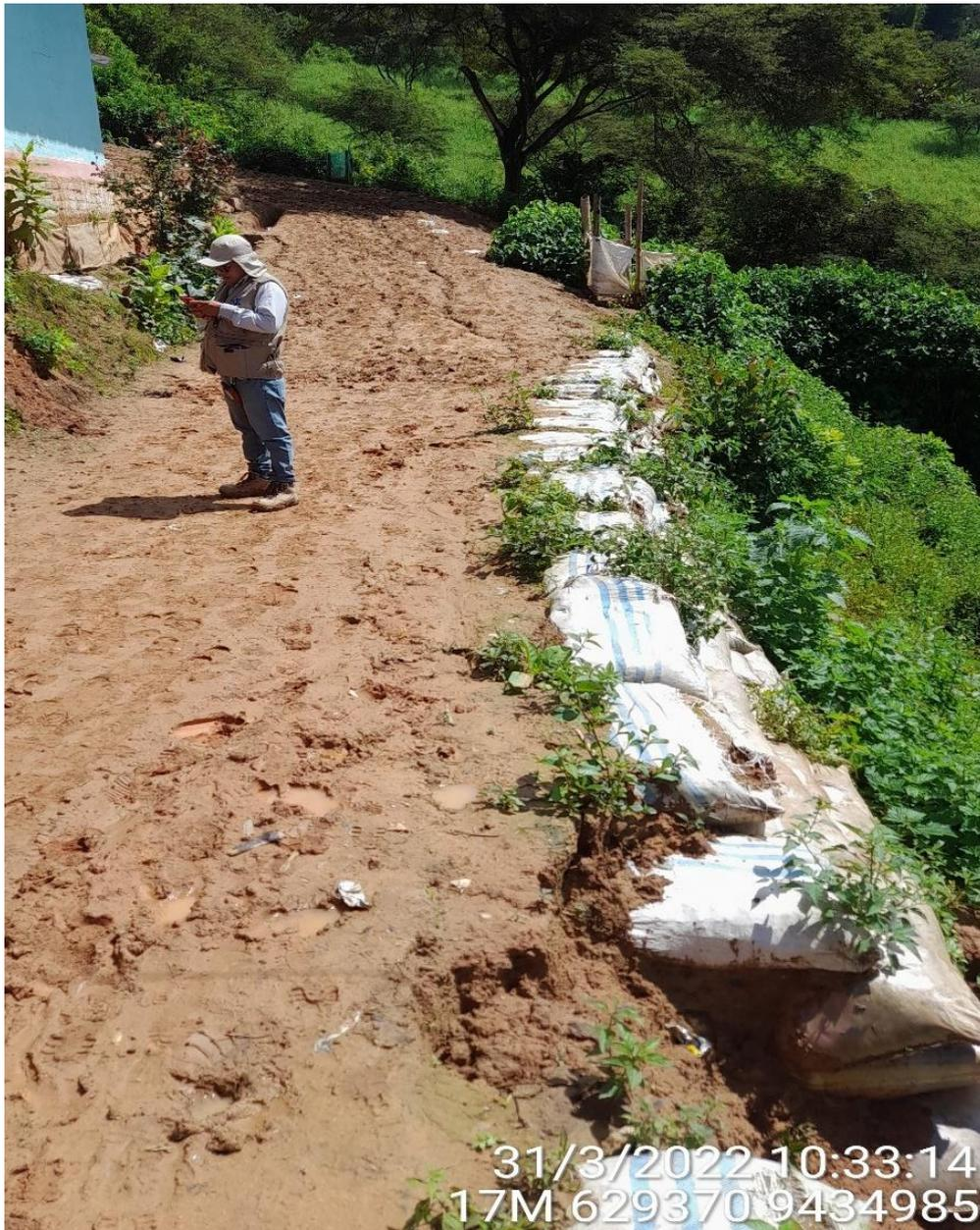
*Figura 16.- Dique conformado con geobolsas (sacos de arena) para evitar erosión y derrumbes en talud de la calle Palmeras, en estado precario, debido a la ocurrencia de las precipitaciones y saturación de los suelos*
