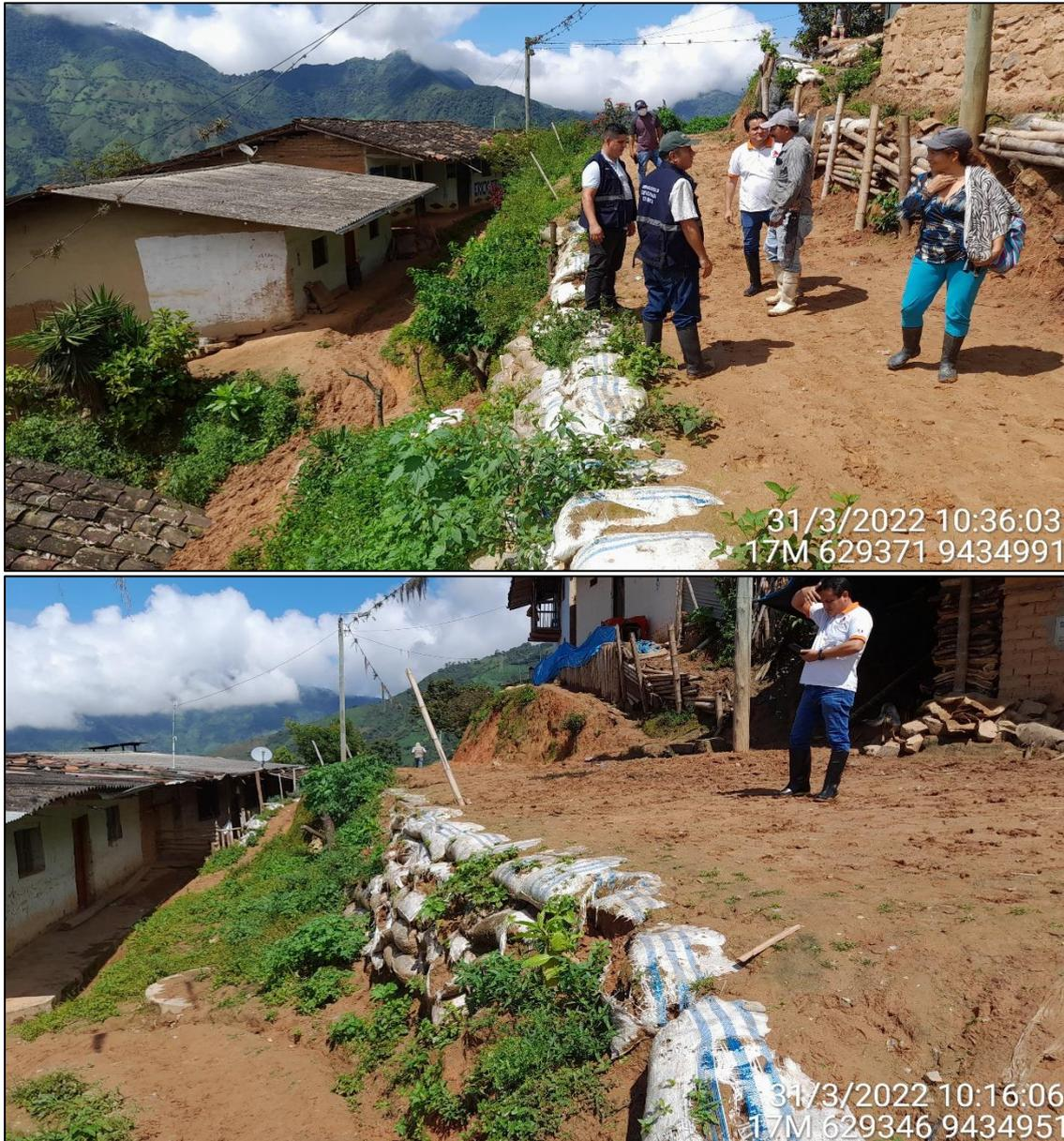
*Figura 15.- Los taludes en la parte baja de la calle Las Palmeras, constituyen zonas susceptibles a derrumbes o caída de suelos y podrían afectar viviendas aledañas*
