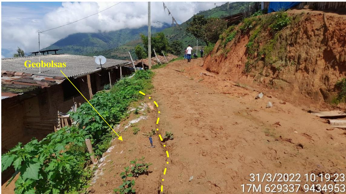
*Figura 18.- Asentamiento diferencial del suelo de 20 cms en la parte posterior del dique conformado (geobolsas) como estructura de contención*
