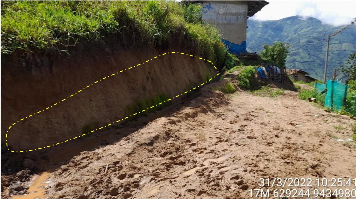
*Figura 10: Afloramientos de granitos meteorizados en los taludes ubicados en la calle Las Palmeras*
