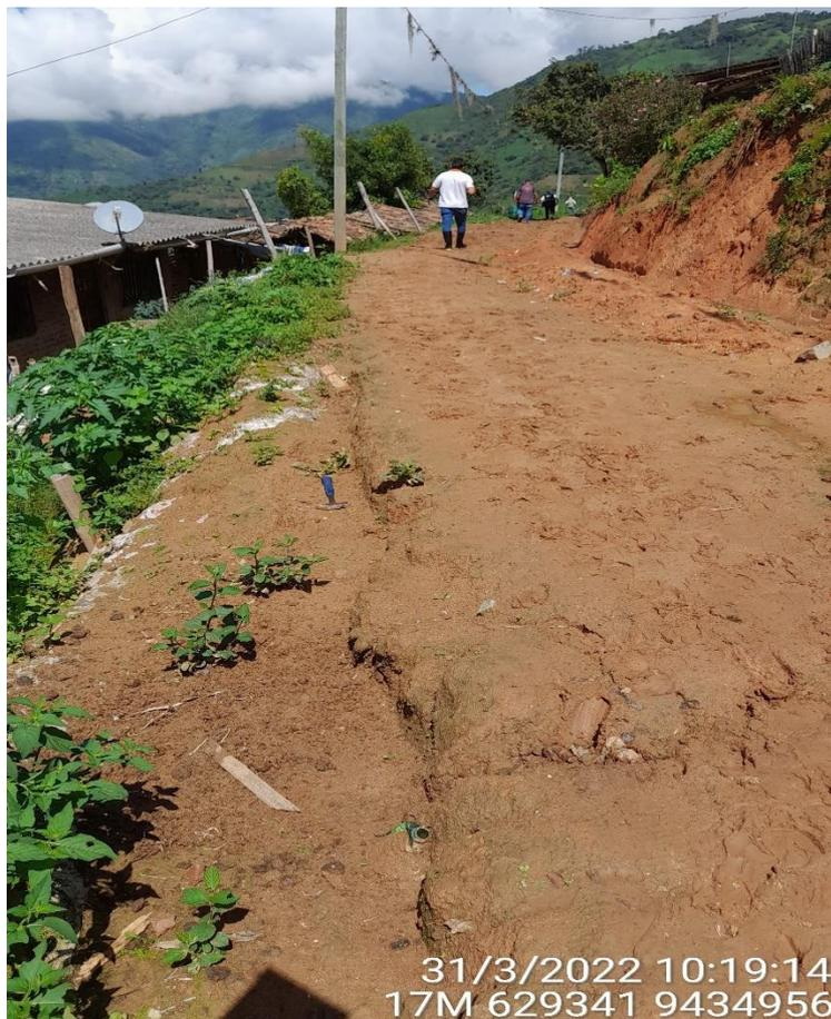
*Figura 19.- Los asentamientos diferenciales se relacionan con la ocurrencia de las precipitaciones pluviales debido a que el agua se infiltra hacia el subsuelo*
