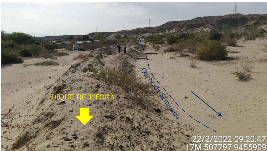
Figura 14.- Cauce de la quebrada Seminario que ha sido colmatado parcialmente por residuos sólidos arrojados por los pobladores
