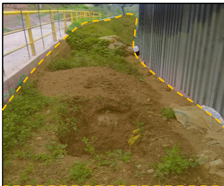
FOTO 8: MATERIAL EXCEDENTE DISPUESTOS COMO RELLENO
