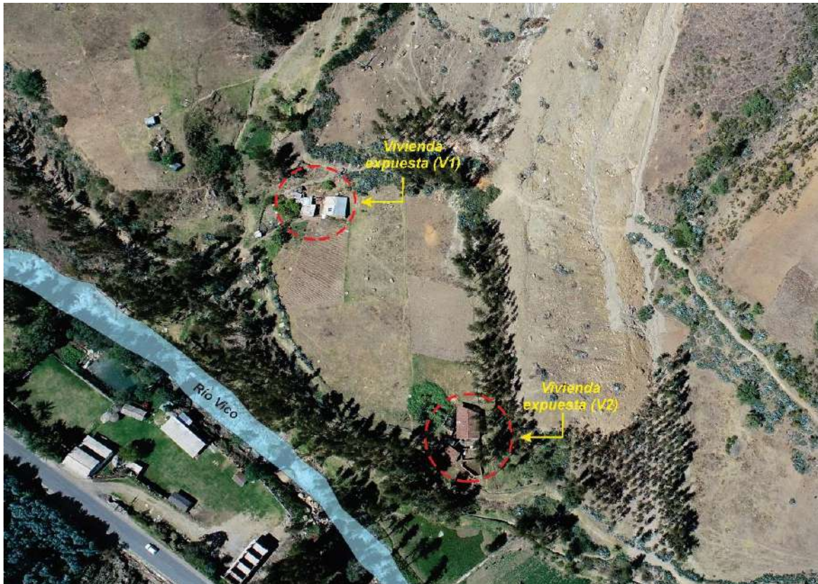
Figura 23. Viviendas expuestas al deslizamiento, vivienda (V1) ubicada a 38.5 m y la vivienda (V2) ubicada a 26 m del deslizamiento.
