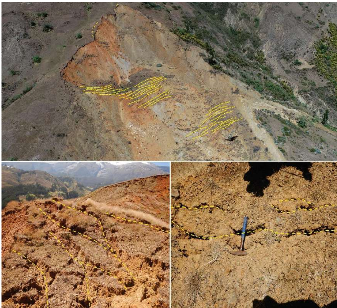
Figura 20. Agrietamientos transversales continuos.
