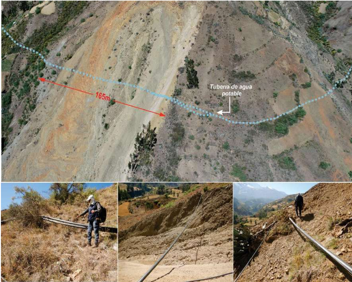
Figura 21. Vista de la tubería que pasa por medio del cuerpo del deslizamiento, que afectó la reactivación del evento.
