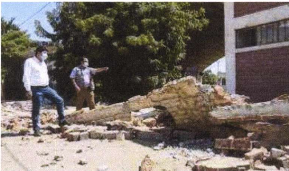
Figura 10. Efectos del sismo de 6.1Mw ocurrido el 30 de julio de 2021 en el sector Educación Región Piura.
