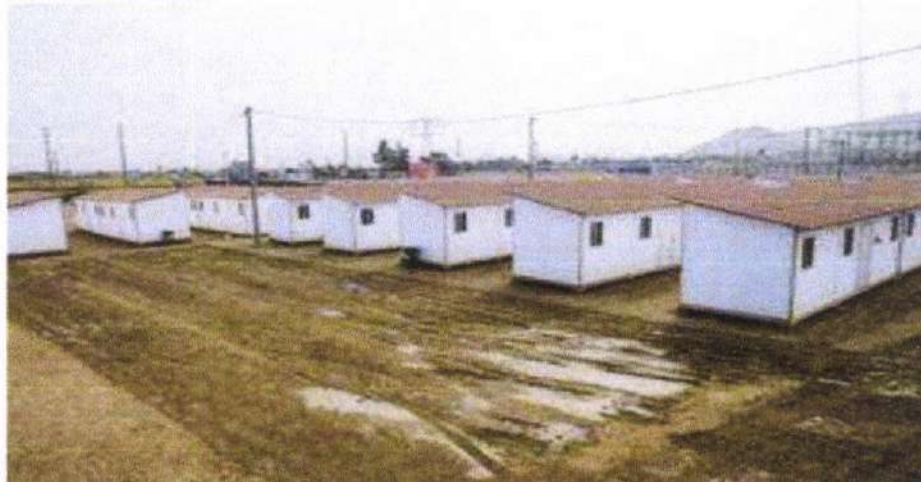
Figura 8. Modulo temporal de vivienda por el sismo de 6.1 Mw del 30 de julio de 2021 para distritos afectados.
