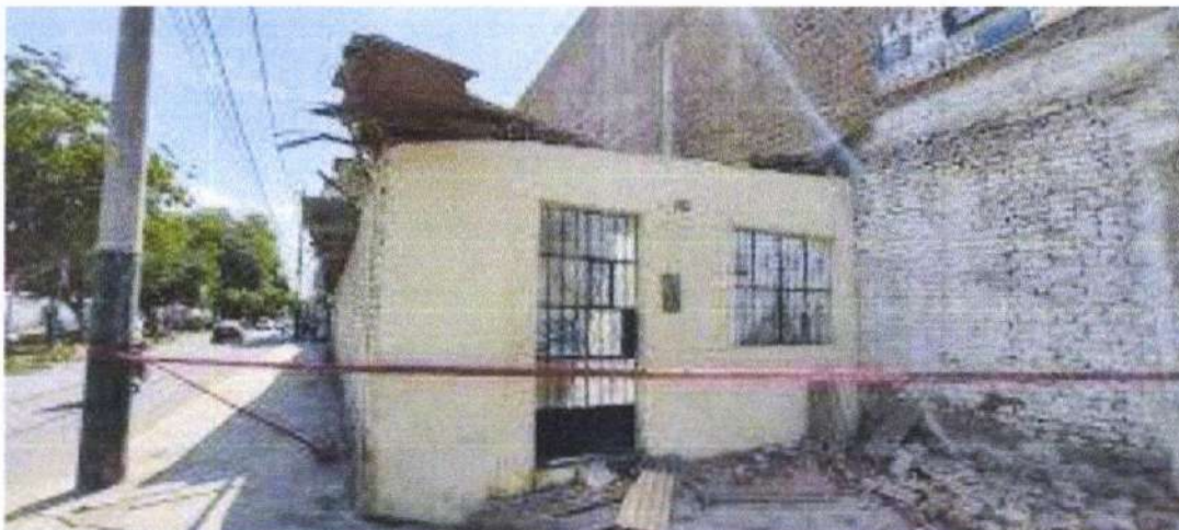
Figura 7. Efectos del sismo de 30 de julio de 2021 en el sector Vivienda Región Piura.
