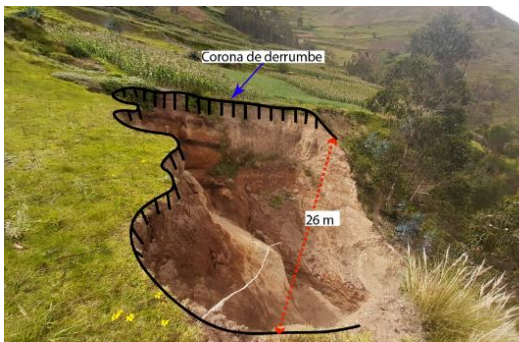
Figura 23. Vista del derrumbe, con dirección al sur, tiene un ancho promedio de 26 m, ubicado con coordenadas UTM (WGS 84): 357583 E; 8856285 N.
