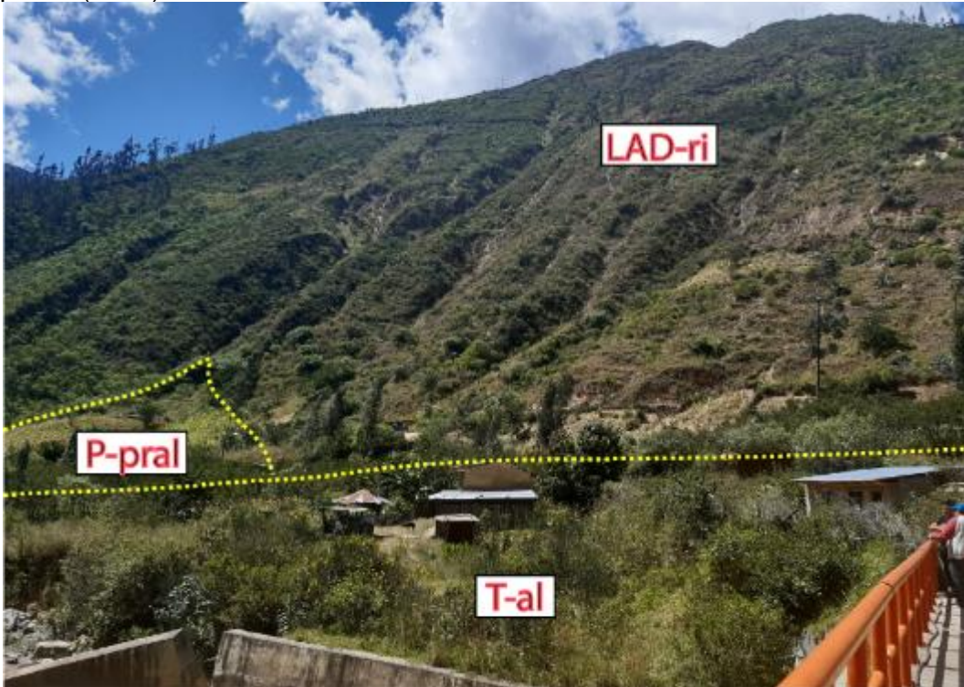
Figura 9. Subunidades geomorfológicas conformadas por ladera disectadas en roca intrusiva (LAD-ri), piedemonte proluvial (P-pral) y terraza aluvial (T-al).
