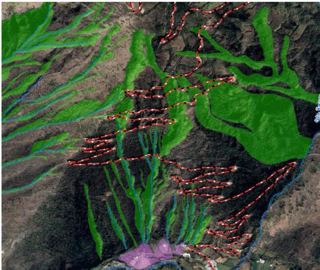
Figura 30: Vista del flanco noroeste del cerro Atopacha se encuentra disectada por erosión en cárcavas, afectando en varios tramos la trocha carrozable que conecta el sector Yanacocha y Racray
