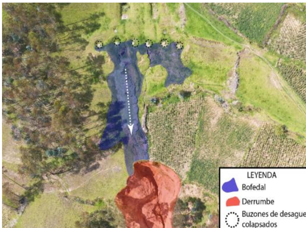
Figura 22. Vista del bofedal que se formó por el colapso de los buzones de desagüe UTM (WGS 84): 357633.80 E; 8856313.21 N, sobresaturando el terreno y en consecuencia desencadenando un derrumbe.
