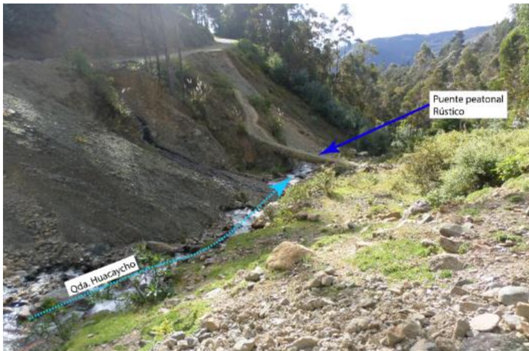
Figura 13. Vista del puente peatonal aguas debajo de la trocha carrozable, Mosca – Muñaura.
