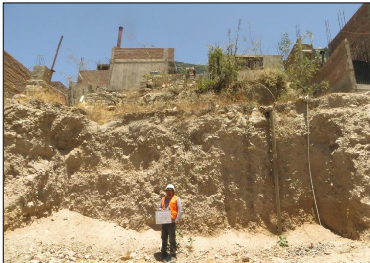
Figura 7.2. Talud de roca en el distrito de Alto Selva Alegre
