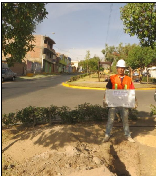
Figura 7.1. Excavación de calicatas en el distrito de Alto Selva Alegre
