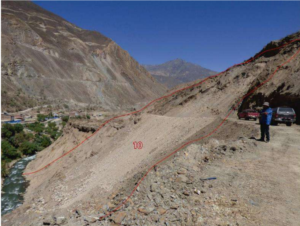
Figura 23. Derrumbes en la margen derecha del río Churín, identificado con el ID 10 en el mapa 4 del anexo 1.
