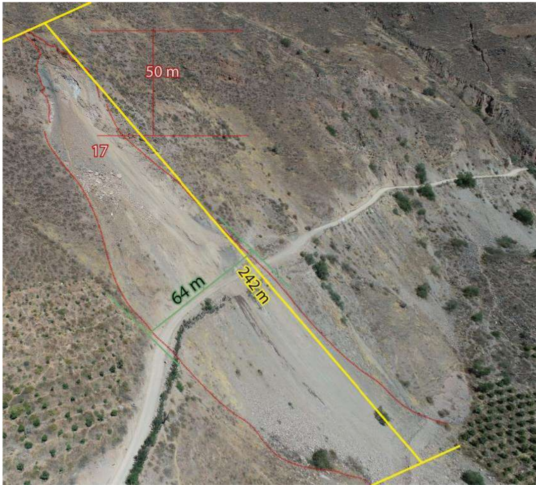
Figura 19. Dimensiones del derrumbe suscitado en abril del 2022.
