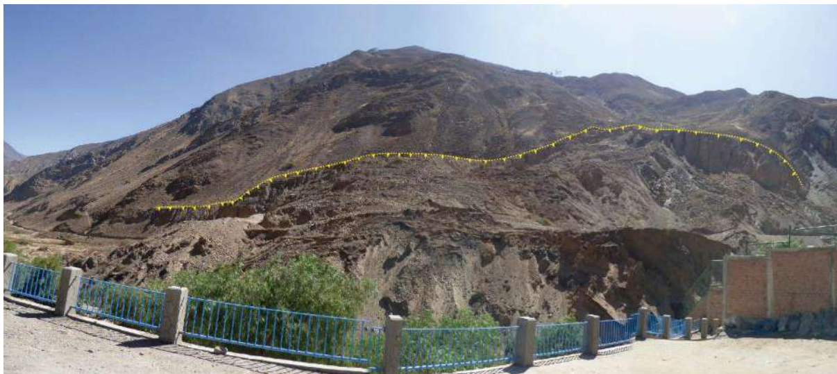
Figura 18. Deslizamiento con código 1.7, identificado en las coordenadas promedio UTM, WGS 84, 18s X:294361; Y:8803643, en la margen derecha del río Huaura.
