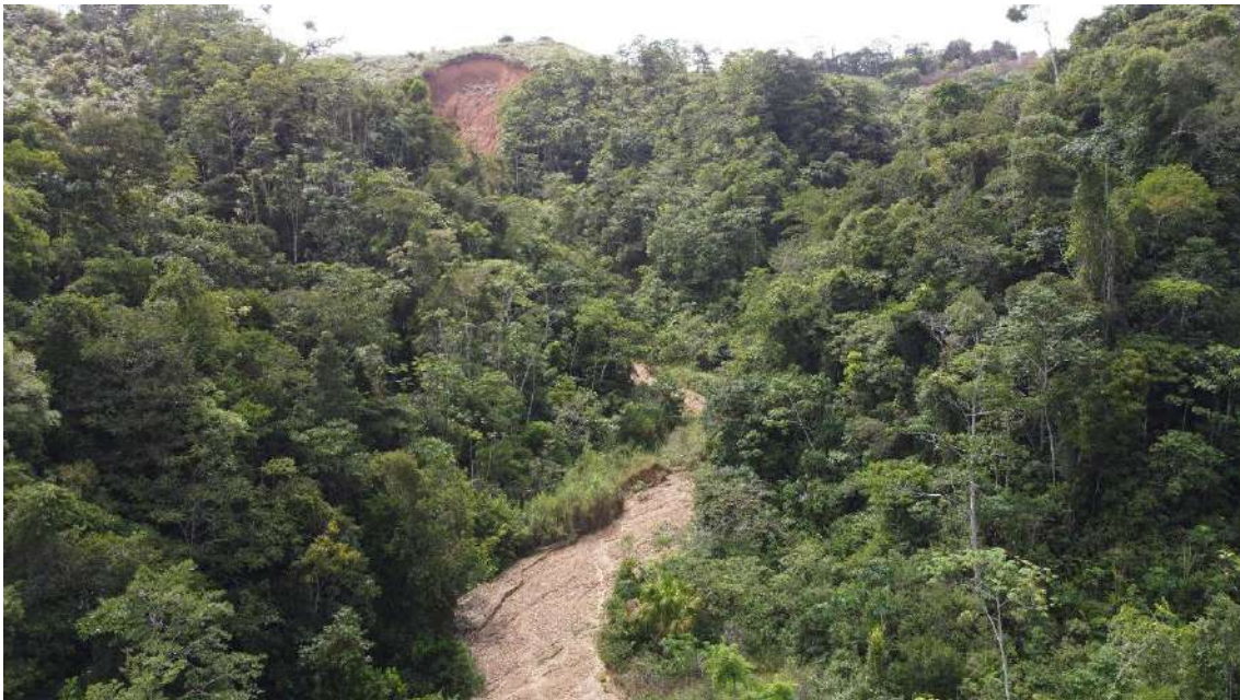
Figura 29. Vista de la zona de inicio del flujo de detritos.
