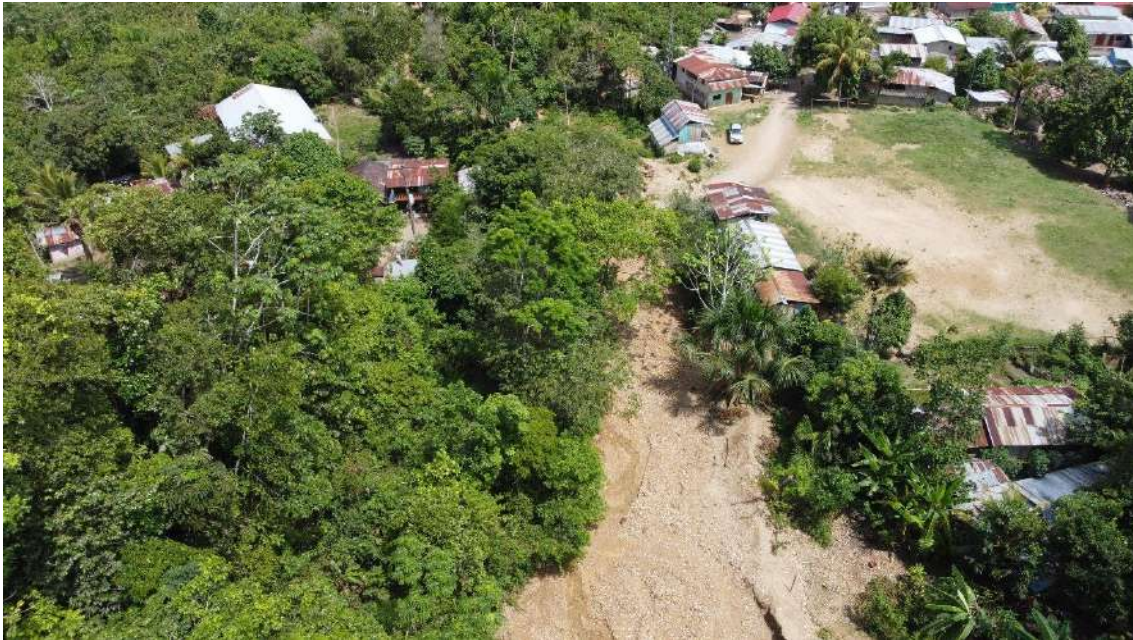
Figura 35. Viviendas y servicios públicos expuestos.
