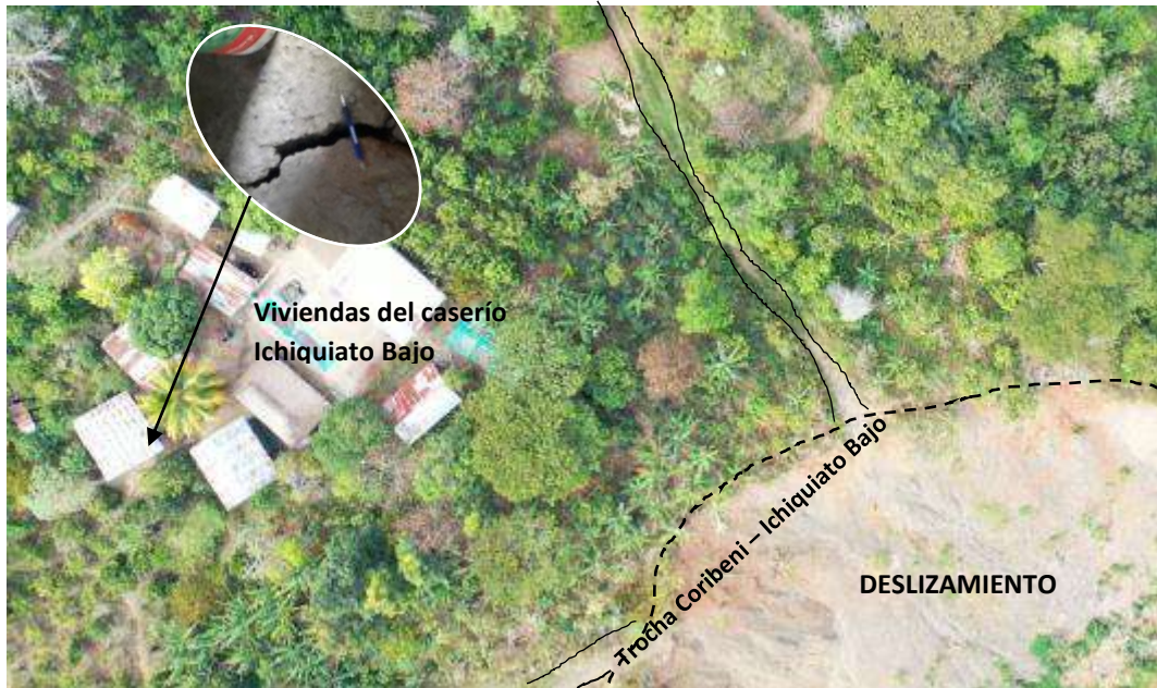
Fotografía 16. Viviendas ubicadas a 35 m de la escarpa principal del deslizamiento de Ichiquiato Bajo. Se detectó agrietamientos de 2m con aperturas de 1 cm, en dirección a la escarpa principal del deslizamiento.
