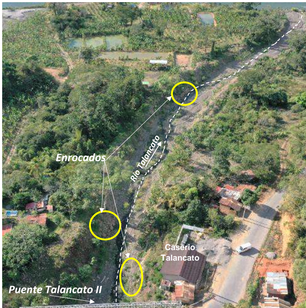
Fotografía 24. Obras realizadas después del flujo de detritos de marzo de 2020.
