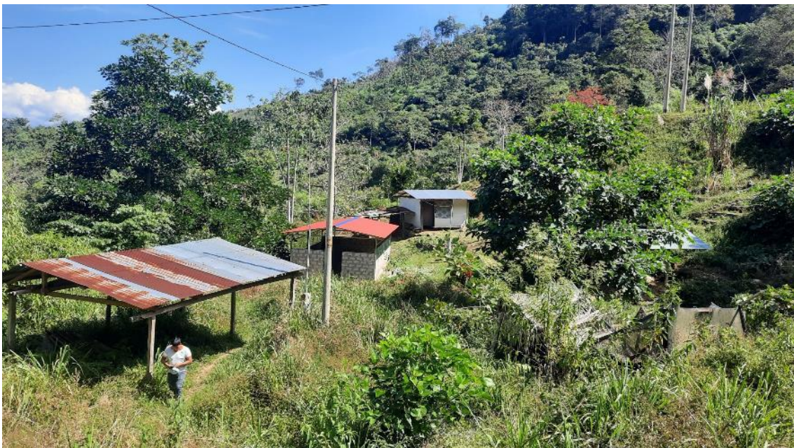
Fotografía 8: Viviendas en la margen derecha de la quebrada Tarancato. Se observa 04 de las 07 viviendas deshabitadas y el poste de alumbrado público reinstalado después del evento.
