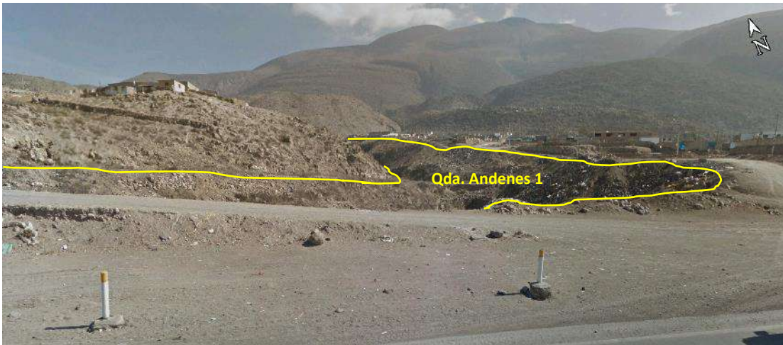
Figura 34. Sector alto de la quebrada Andenes 1 (Coordenadas UTM WGS84 218868 E, 8196649 N).
