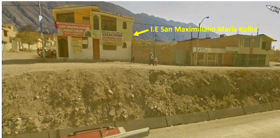
Figura 42. I.E. San Maximiliano María Kolbe, según la simulación se vería afectado por lahares con un nivel de peligrosidad moderado (Coordenadas UTM WGS84 220981 E, 8194921 N).
