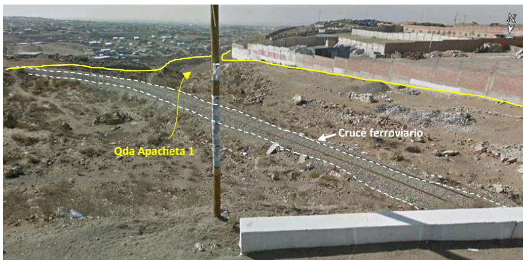
Figura 56. Cruce ferroviario en la quebrada Apacheta 1 (Coordenadas UTM WGS84 218392 E, 8196605 N).
