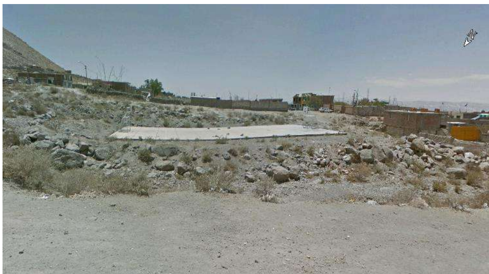
Figura 46. I.E. Campo deportivo va cerca al cauce de la quebrada Escalerilla 4 (Coordenadas UTM WGS84 220262 E, 8195770 N).
