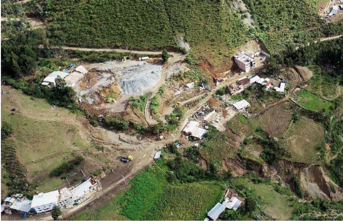
Fotografía 1. Vista panorámica del sector de Carhuabamba afectada por deslizamiento Coordenadas UTM: 215511.85 / 9141316.73, Zona 18.
