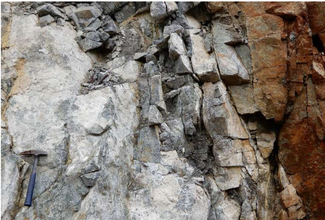
Fotografía 3. Macizo medianamente fracturado compuesto por Tonalita y Granodiorita. Coordenadas UTM: 214922.30 / 9140730.42, Zona 18.
