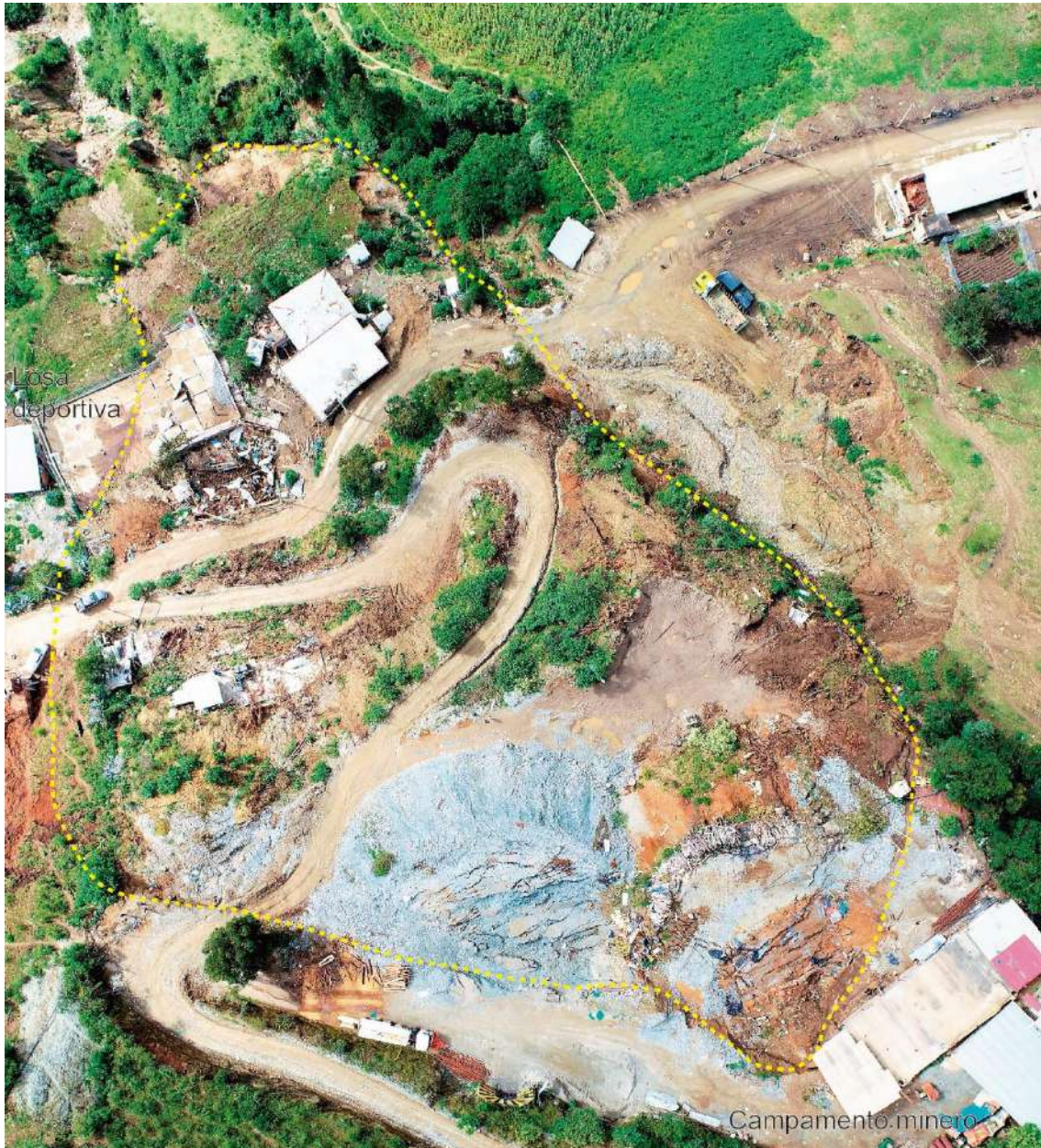
Figura 8. Delimitada con línea amarilla se observa la vista horizontal del deslizamiento ocurrido en el centro poblado Carhuabamba entre el campamento minero y la losa deportiva. Coordenadas UTM: 215511.00 / 9141315.98, Zona 18.
