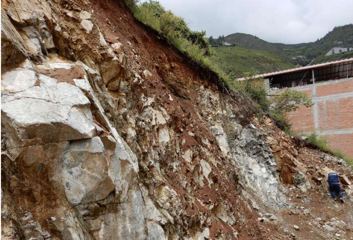
Fotografía 4. Macizo de tonalitas y granodioritas medianamente fracturado con superficie completamente meteorizado. Coordenadas UTM: 214922.30/9140730.42, Zona 18.
