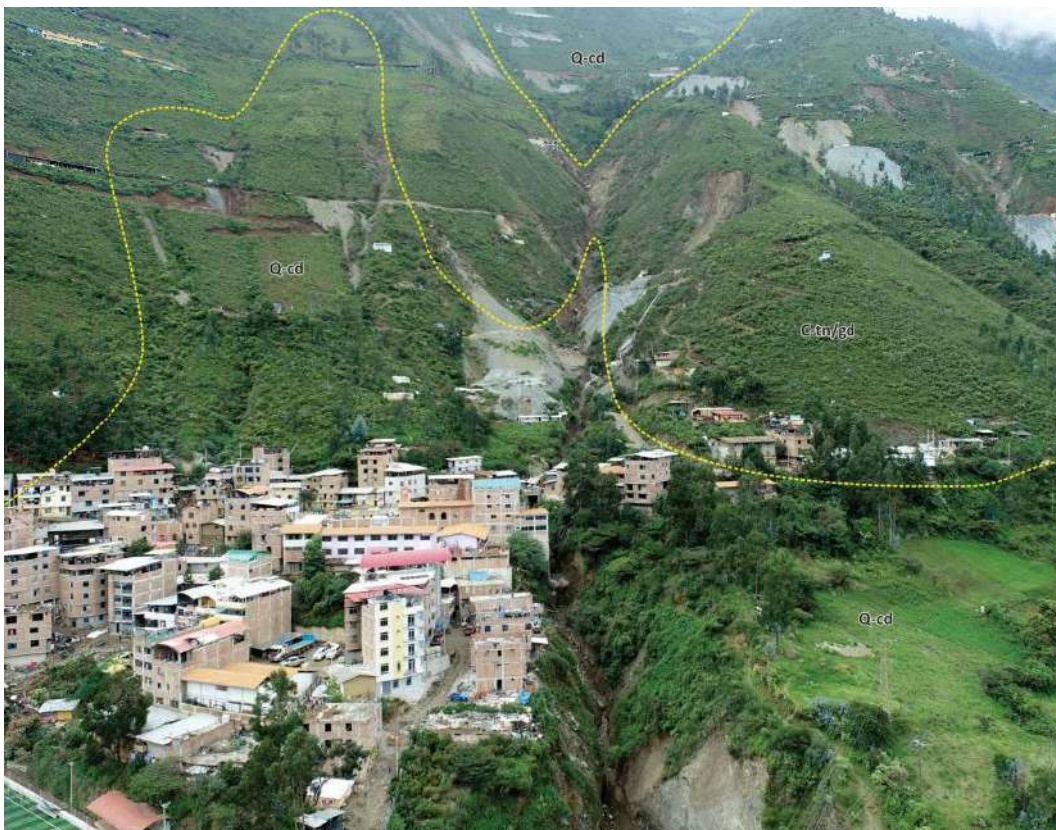
Figura 3. En el sector de Pueblo Nuevo, se observa los depósitos coluviodeluviales (Q-cd) y el macizo compuesto de tonalitas, granodioritas (C-tn/gr), cubiertos parcialmente por arbustos, pastos naturales y construcción de viviendas.
