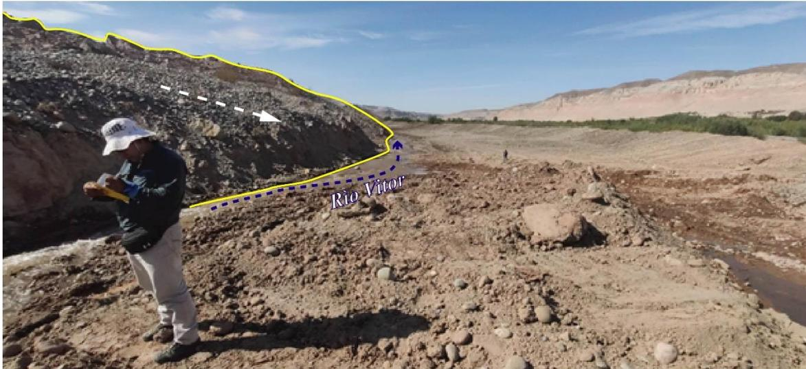
**Figura 2.** Se observa el avance del pie del deslizamiento de Punillo, intervenido con obras de mitigación realizadas para ampliar, contener el cauce, evitar embalses y desembalses que afecten terrenos de cultivo. La línea amarilla muestra el frente activo del deslizamiento y la flecha blanca indica la dirección aproximada hacia el río Vitor.
