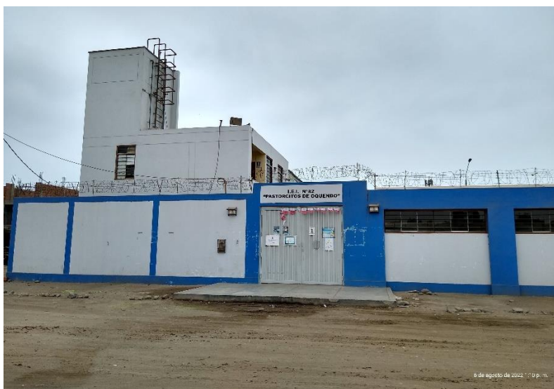
Foto N°6. I.E.I. N° 82, Pastorcitos de Oquendo. Vías sin asfaltar
