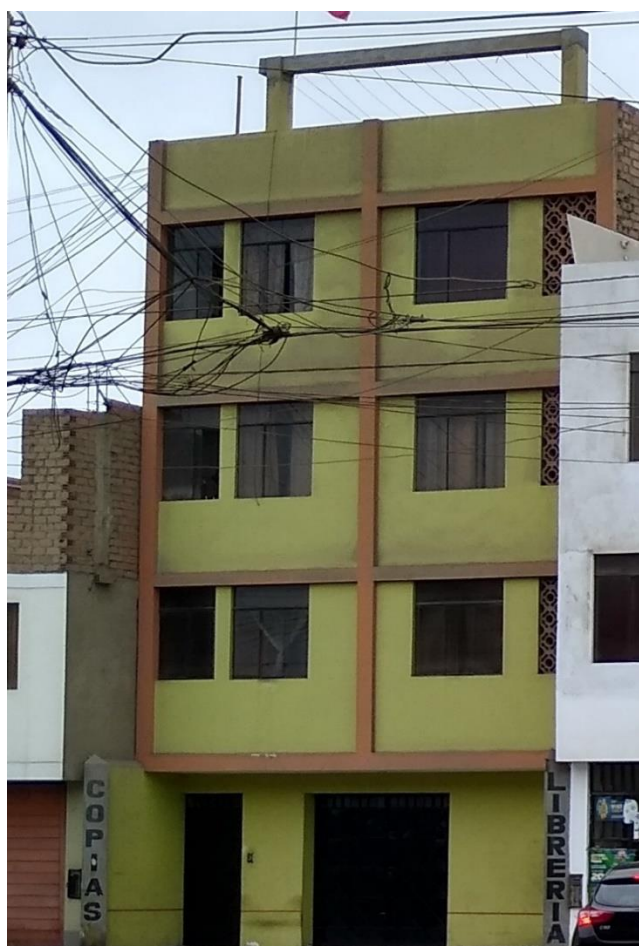
Foto Edificación de 4 pisos. Mz P lote 10
