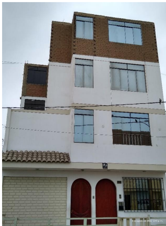
Foto N° 8. Vivienda de 4 pisos con material noble. Mz B10 lote 11
