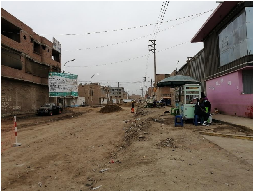
Foto N° 9. Obras de asfaltado en el Jr. Brasilia
