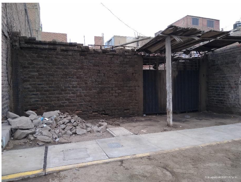
Foto Edificación de 1 piso, techo de madera. Mz P lote 32
