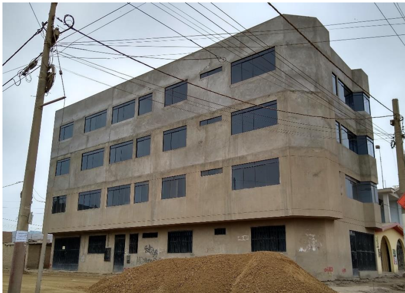
Foto N°1. Edificio de viviendas, Mz B18 lote 1
