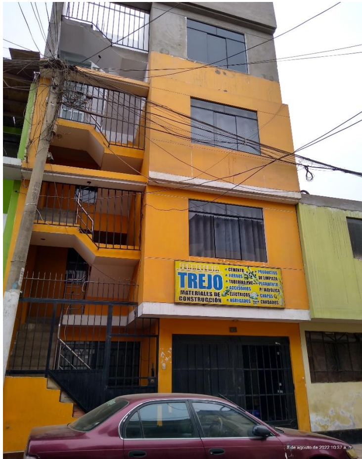
Foto . Predio de 4 pisos. Mz P lote 3
