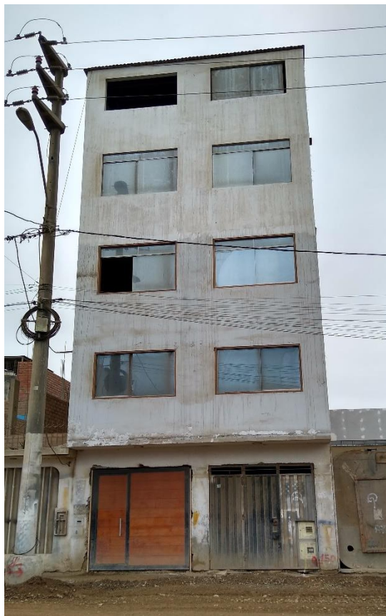
Foto N°2. Edificio de 5 pisos Mz B19 lote 11
