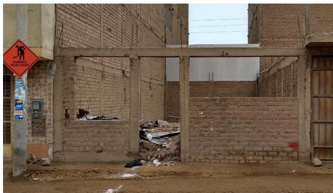
Foto Nº 3.- Terreno cercado. Mz B19 lote 21
