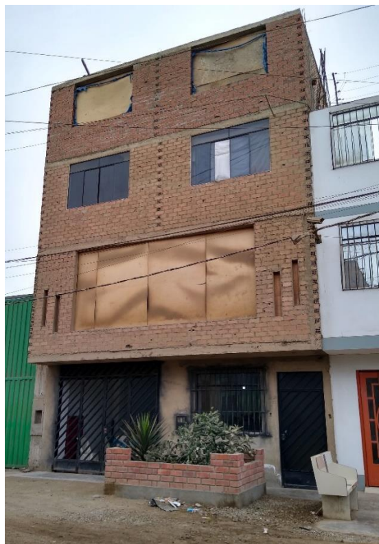
Foto N° 7 . Vivienda con material noble de 4 pisos en la Mz B8 lote 22
