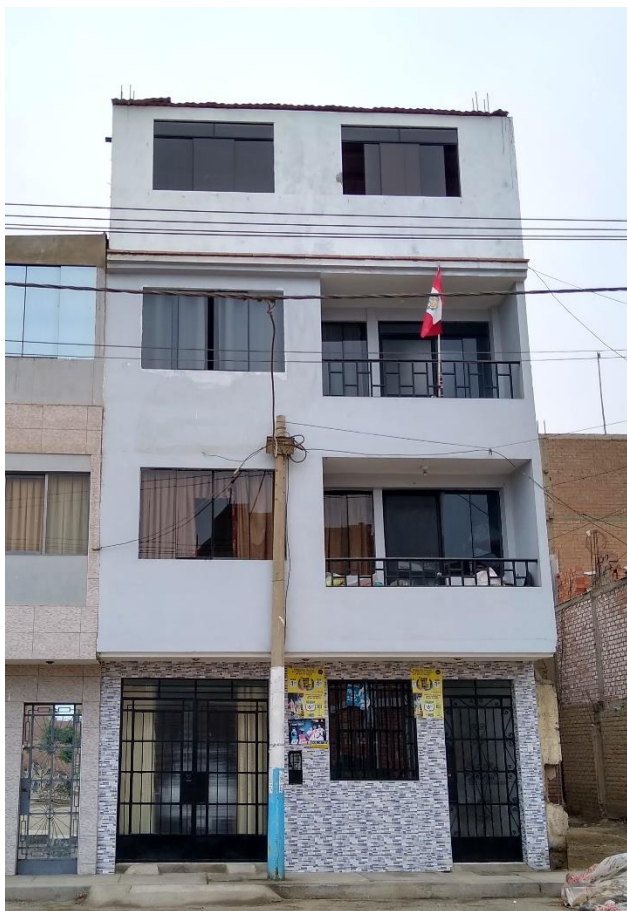
Foto . Edificio multifamiliar de 4 pisos. Mz O lote 1
