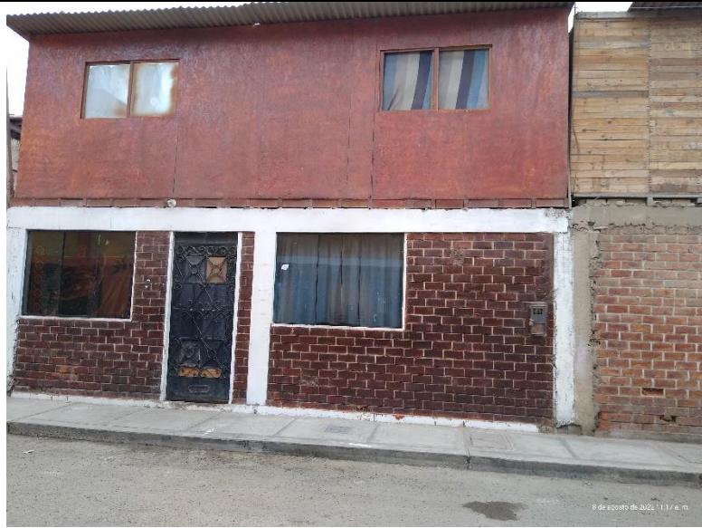
Foto . Predio de 2 pisos, primer piso de ladrillo y segundo de madera. Mz Ñ lote 11
