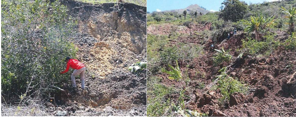
Fotografía 3. Detalle del escarpe principal del deslizamiento en marzo del 2022. Fuente: Municipalidad Distrital de San Felipe. Ubicación: E: 686919; N: 9361298; Z: 1742.
