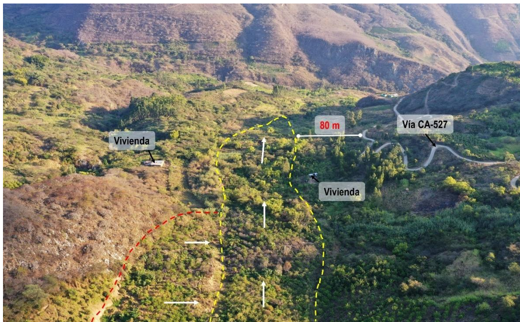
Figura 13. Vista de la parte baja del deslizamiento (en línea amarilla) donde se aprecia la parte final de uno de los deslizamientos secundarios (en línea roja), las viviendas afectadas y la vía CA-527.
