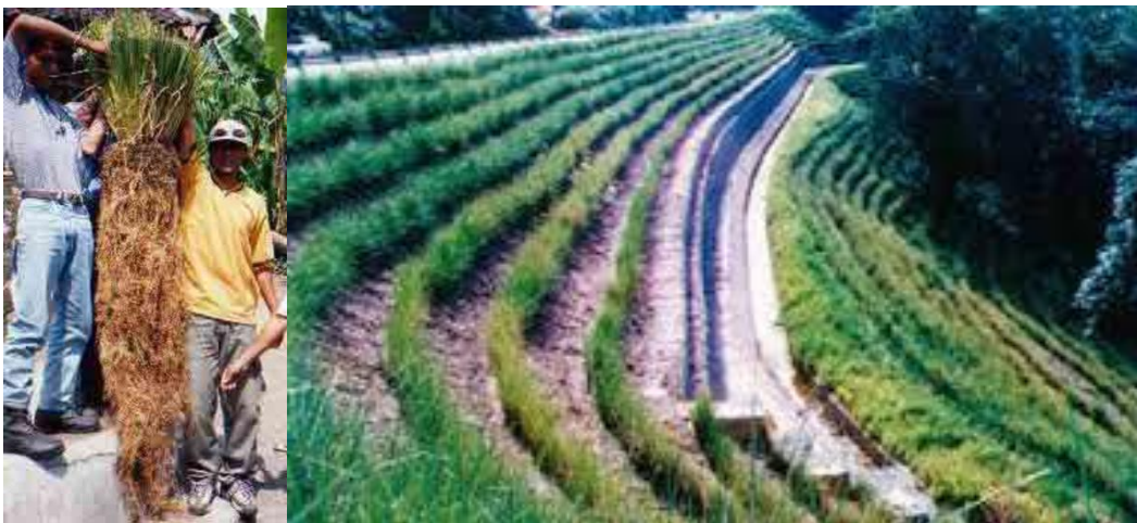
Fotografía 4. Ejemplo de bioingeniería con arbusto (vetiver) en taludes de materiales sueltos.
