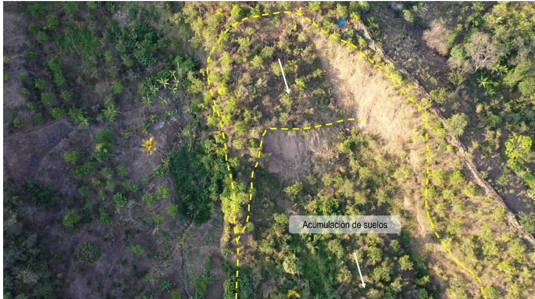
Figura 3. Vista de los suelos acumulados en el escarpe principal del deslizamiento evaluado.
