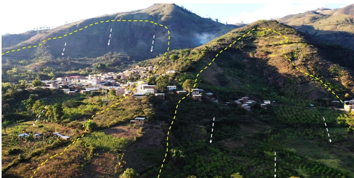
Figura 8. Vista de la parte alta de la zona evaluada, donde se aprecian las viviendas de la localidad de San Felipe y montañas cóncavas debido a los continuos movimientos en masa que las han labrado.
