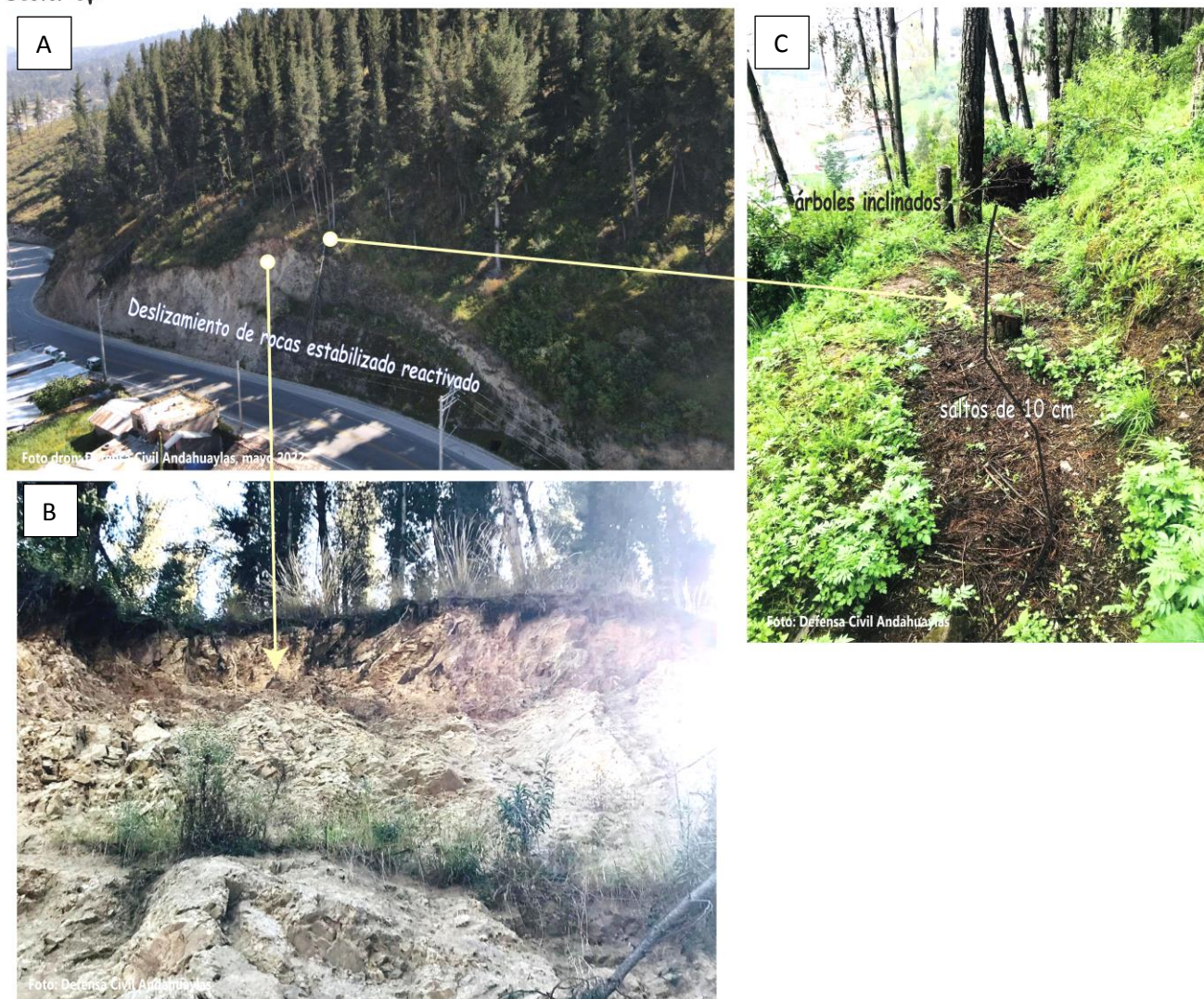
Figura 13. Vista de arboles de más de 20 m de altura en la cabecera del corte de talud de la carretera nacional Andahuaylas a José María Arguedas. A. Deslizamiento estabilizado entre 2017 y 2018, actualmente reactivado. B. caída de rocas en el lado reactivado. C. saltos y vista de arboles inclinados a 4.5 m de la escarpa principal.
