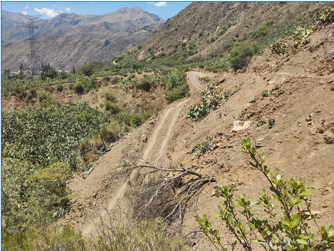
Figura 11: Talud y plataforma inestables de la carretera
