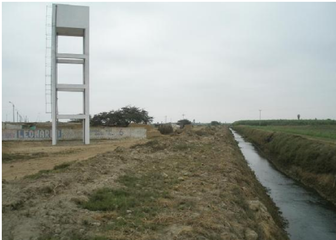
Foto 07: Sector Perla de Macabí, se observa un canal de riego sin revestimiento de concreto.
