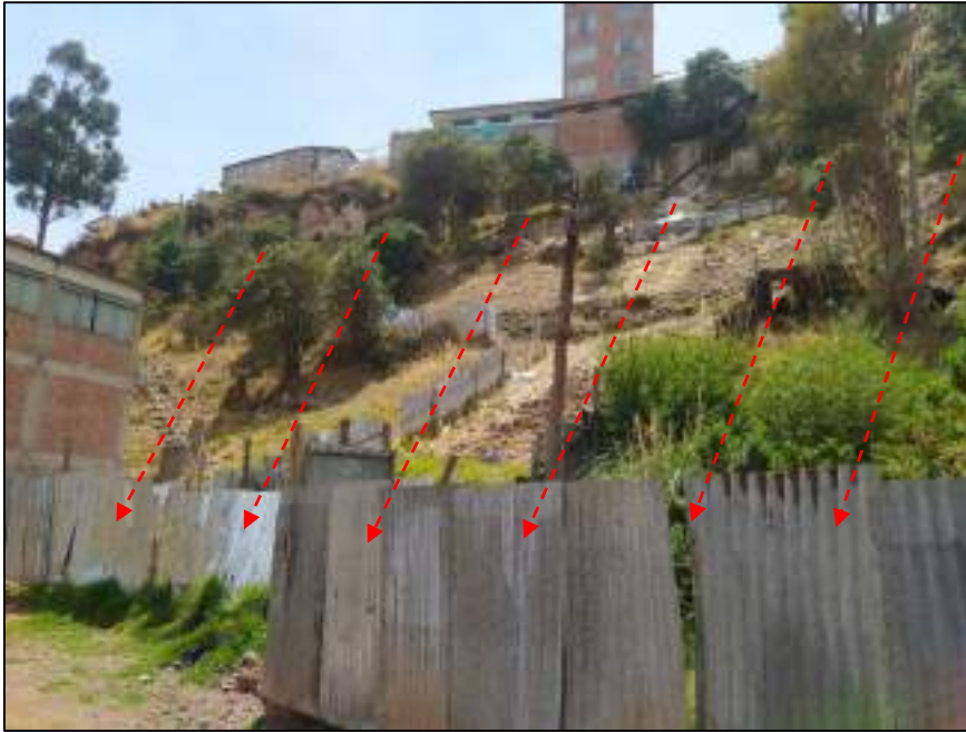
FOTOGRAFÍA 03. Depósitos coluviales con incidencia urbana
