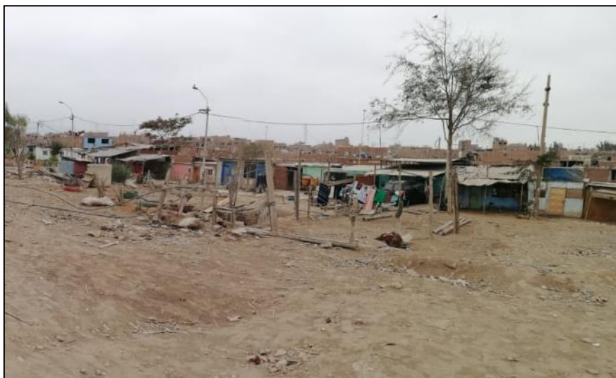
Viviendas ubicadas dentro de la faja marginal, expuestas al peligro por inundación
