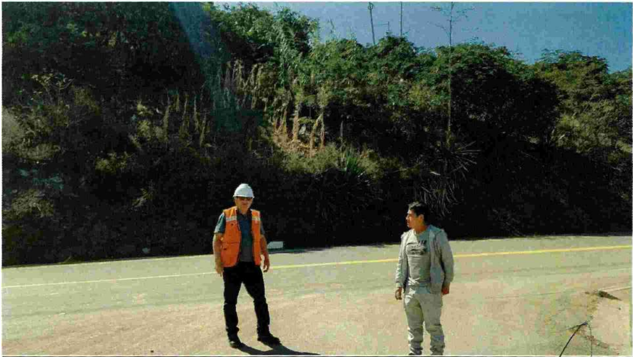
Fotografía 08: Visita Técnica de Campo: Inspección a Kuntur Wasi, zona de deslizamiento. (17/08/2022)
