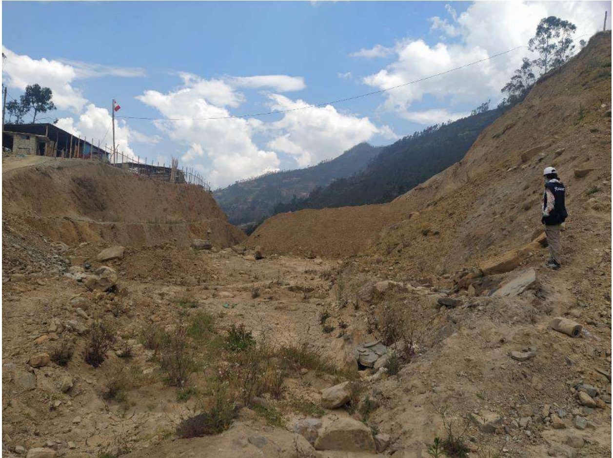
Fotografía 3 Derrumbes en el pie del deslizamiento de Umaccata (parte derecha de la fotografía).
