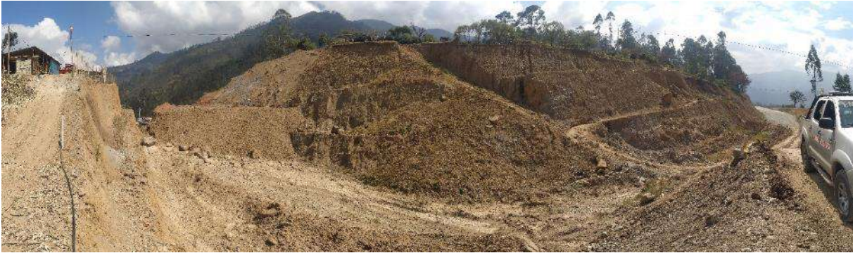
Fotografía 2. Vista panorámica del deslizamiento de Umaccata, muestra el material removido para la apertura de una vía.
