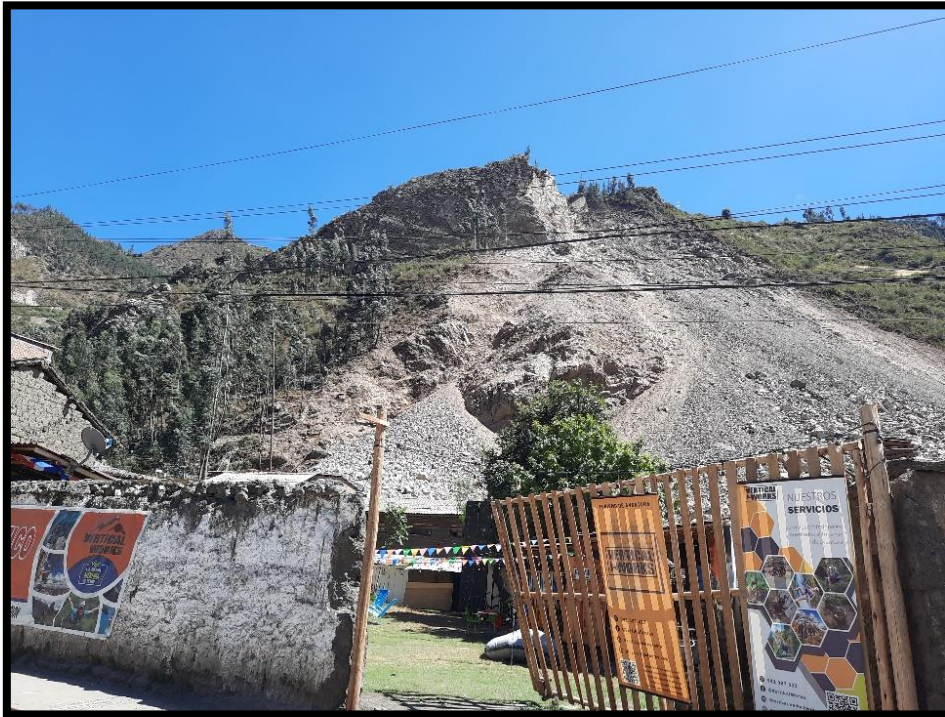
Foto 03. Vista IN SITU del derrumbe
