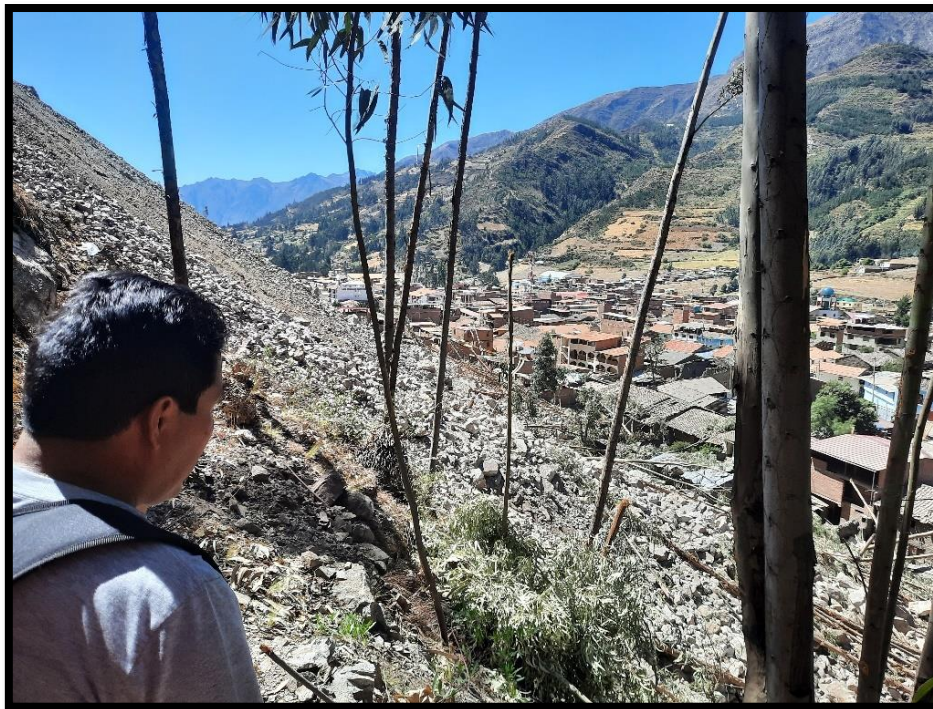
Foto 04. Vista panorámica del cerro Cruz de Shallapa donde se inició el derrumbe
