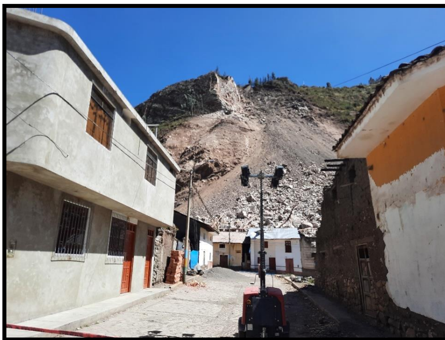
Foto 02. Vista IN SITU del derrumbe
