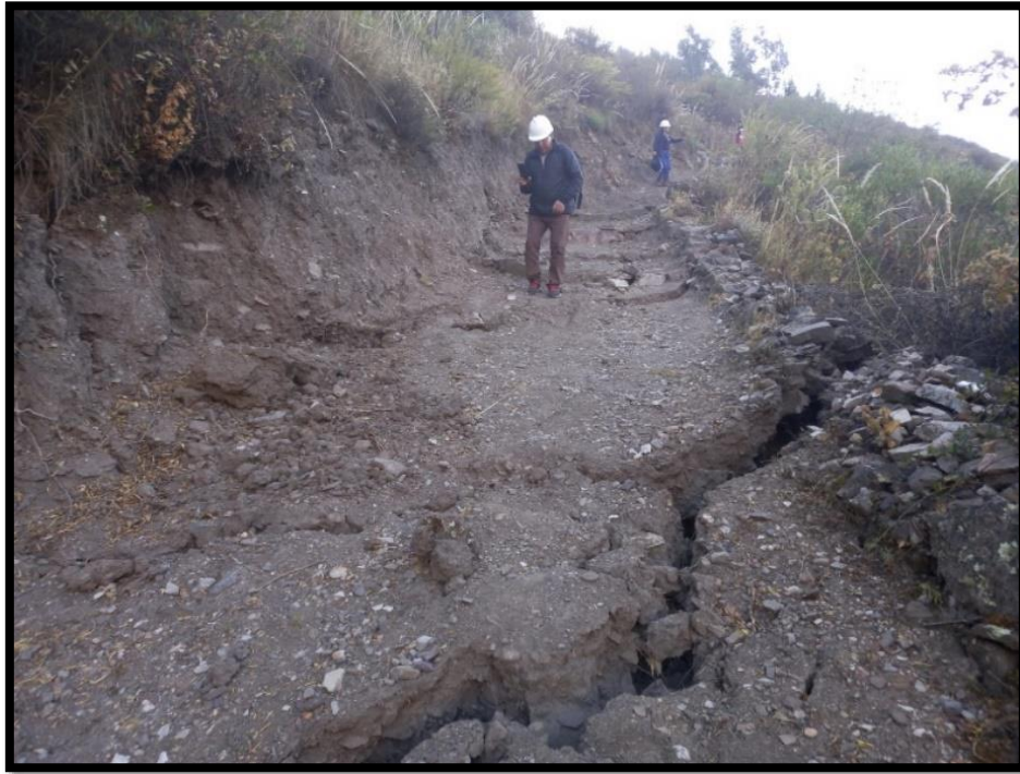
Foto 09. Grietas y rajaduras en la parte alta – zona del mirador
