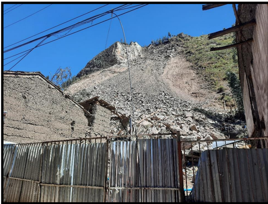
Foto 01. Vista IN SITU del derrumbe
