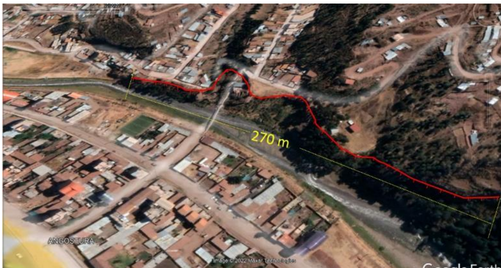
Figura 9. Talud de 270 m donde se producen derrumbes, imagen tomada de Google Earth (2022).
