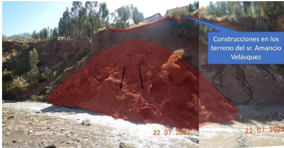
Figura 3. Derrumbe en la propiedad del Sr. Amancio, los materiales derrumbados obstruyeron parcialmente el río.
