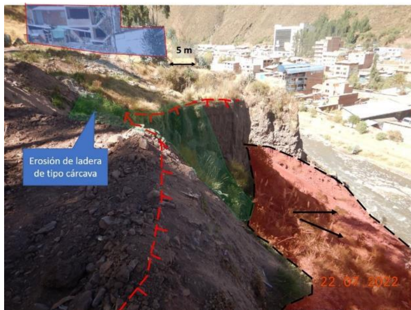
Figura 4. Vivienda que puede ser afectada por una nueva reactivación del derrumbe, además, se aprecia un derrumbe antiguo en el talud con presencia de erosión de ladera tipo cárcava.
