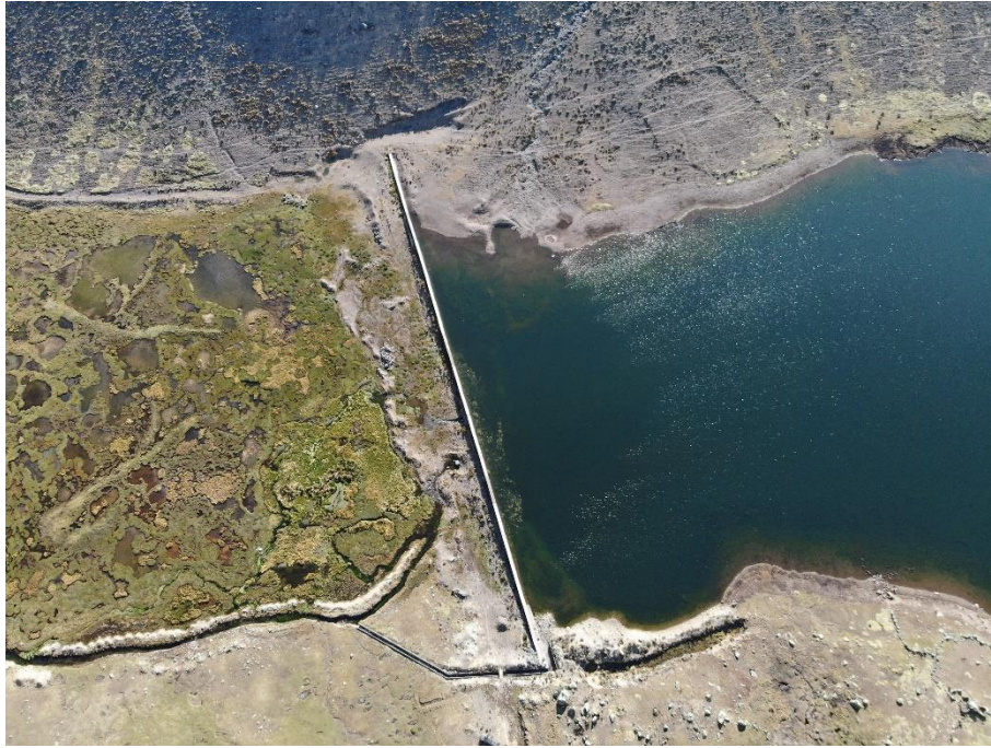
Fotografía 11. Parte del dique, en la margen derecha se encuentra sobre un depósito de un flujo antiguo.
