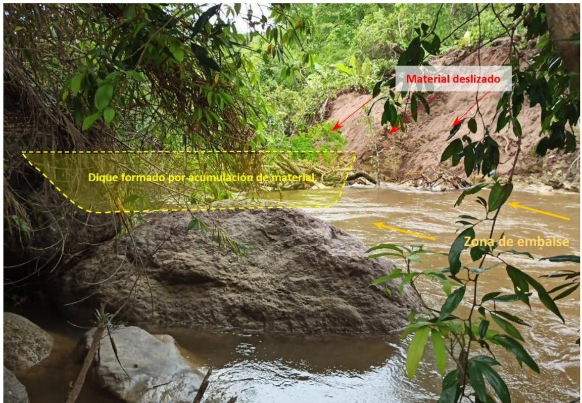
**Figura 12.** Ubicación del dique formado por el material deslizado.
