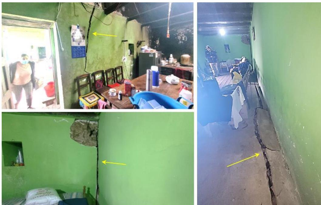
**Figura 17.** Piso y paredes de vivienda muy agrietados. (Coordenadas UTM WS-84 -17S, **Norte:** 9261759 – **Este:** 751766).
