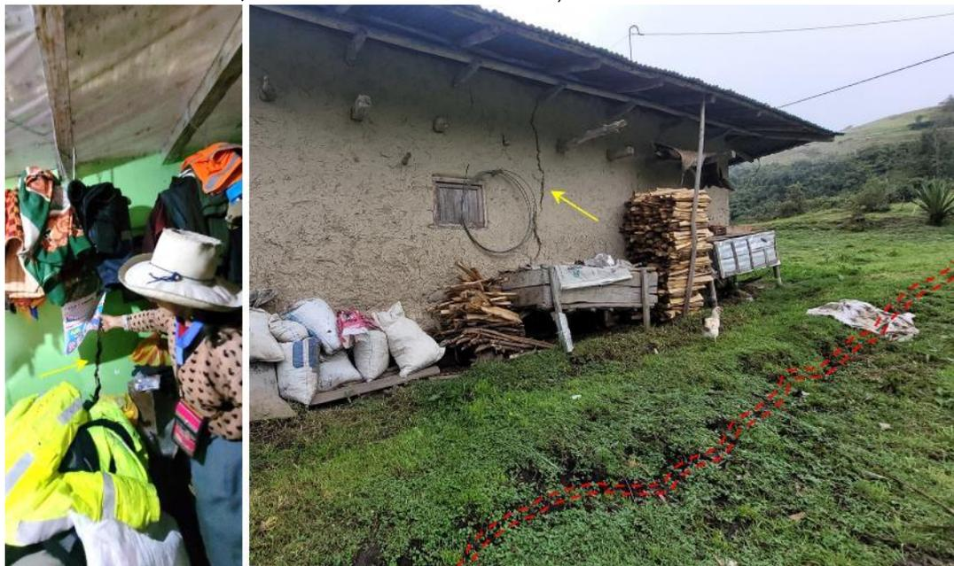
**Figura 19.** Agrietamientos de pared, parte posterior de la vivienda y a una distancia de 4m en el terreno. (Coordenadas UTM WS-84 -17S, Norte: 9261880 – Este: 751811).
