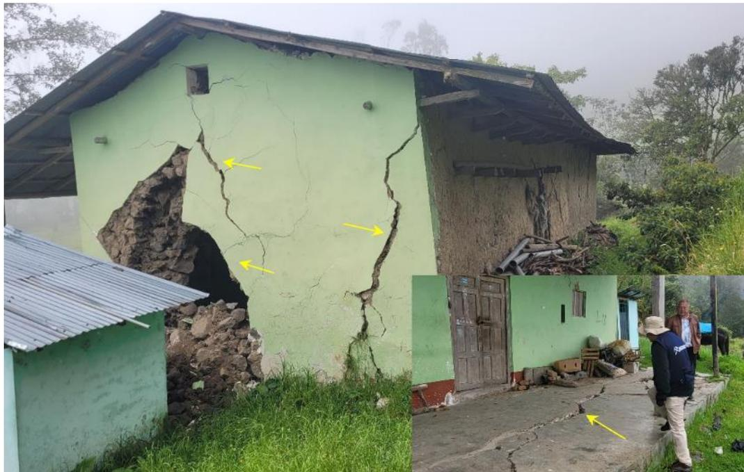
**Figura 18.** Agrietamientos de pisos del frontis de la vivienda y colapso de pared. (Coordenadas UTM WS-84 -17S, Norte: 9261650 – Este: 751661).
