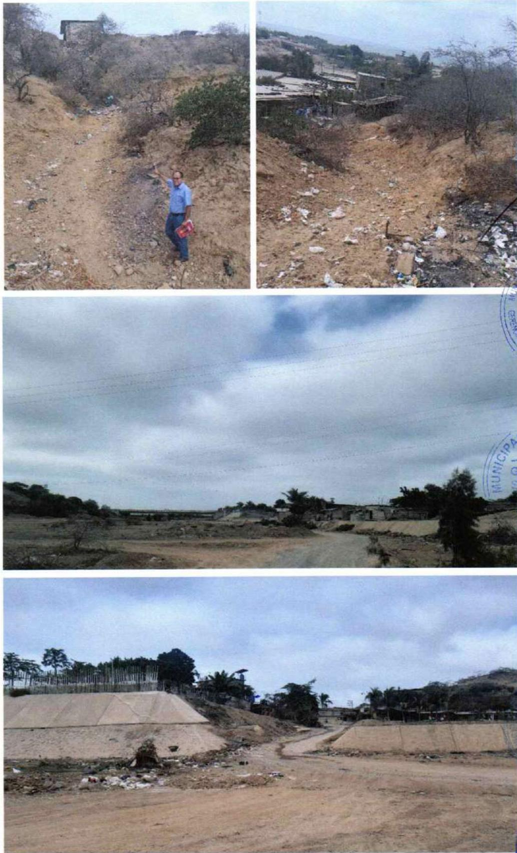
Figura 22. Asentamiento humano La Canteria: se observan cárcavas que luego depositan su material en el cauce de la quebrada El Charán. También se aprecia el estado de la infraestructura de protección existente
