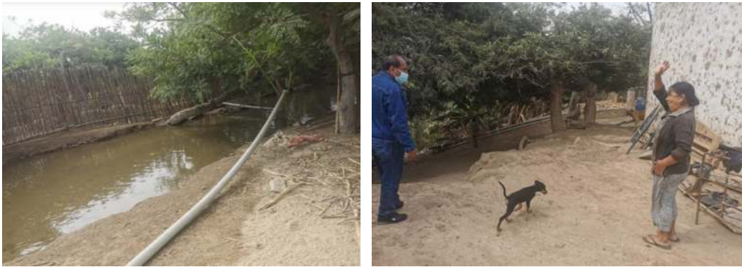
Viviendas en riesgo de ser afectados por desborde del río Zaña y canal de regadío
