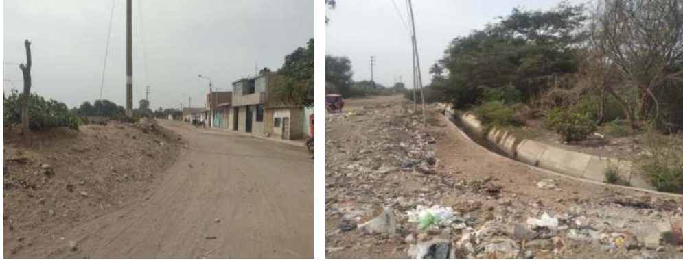
Muro o dique de contención, y canal de irrigación, colmatado de residuos sólidos, falta de mantenimiento
