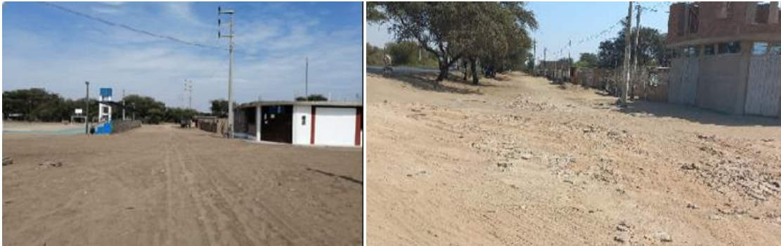
En Centro Poblado El Agropecuario presenta Vivienda consolidadas en su mayoría de material de adobe y calles sin pavimentar
