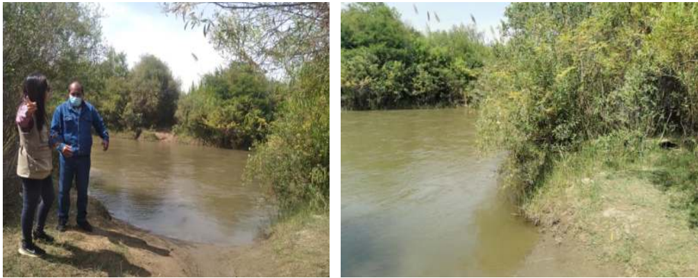
Río Zaña a la altura del sector Pozo 1, muestra erosión del talud margen derecha, por donde se desborda cuando presenta gran avenida de agua
