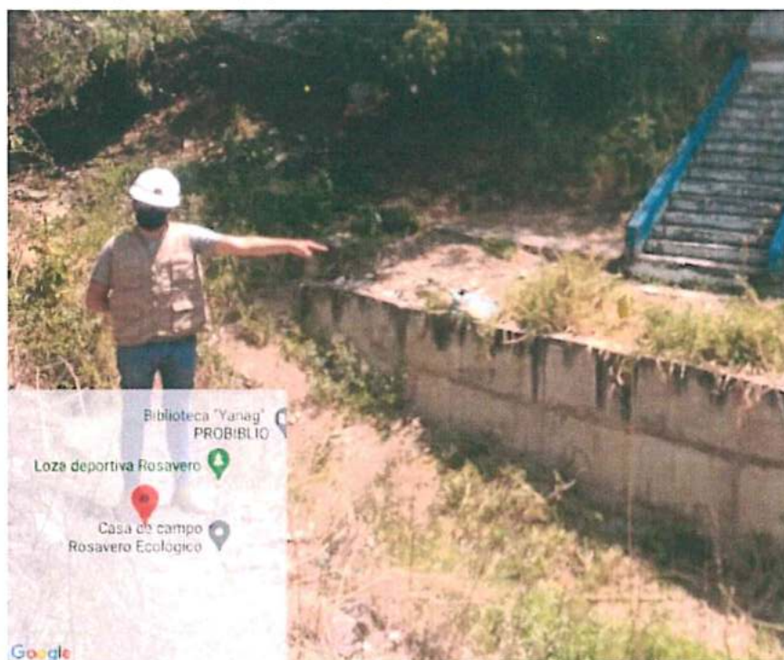
Fotografía N° 12. Visita a sectores críticos, en la localidad Rosavero, en el distrito de Pillco Marca, por parte del equipo técnico para elaboración del PPRD de Huánuco.
