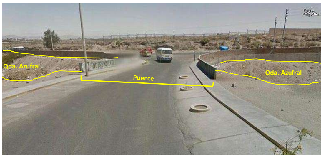
Figura 38. Puente (Punto crítico), construido sobre depósitos de desmonte, quebrada Azufral (Coordenadas UTM WGS84 226994 E, 8191713 N).
