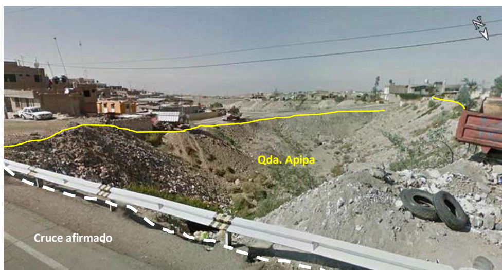
Figura 54. Cruce afirmado (punto crítico), se observa relleno por depósitos antrópicos (desmonte y basura) (Coordenadas UTM WGS84 222521 E, 8193501 N).
