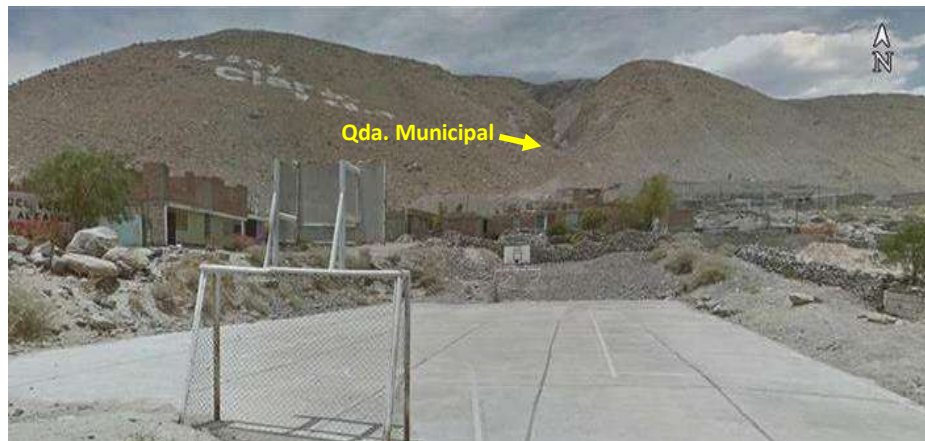
Figura 52. Campo deportivo (punto crítico) construido sobre una de las bifurcaciones de la quebrada Municipal, se encuentra con un nivel de peligrosidad moderado (Coordenadas UTM WGS84 222821 E, 8194247 N).
