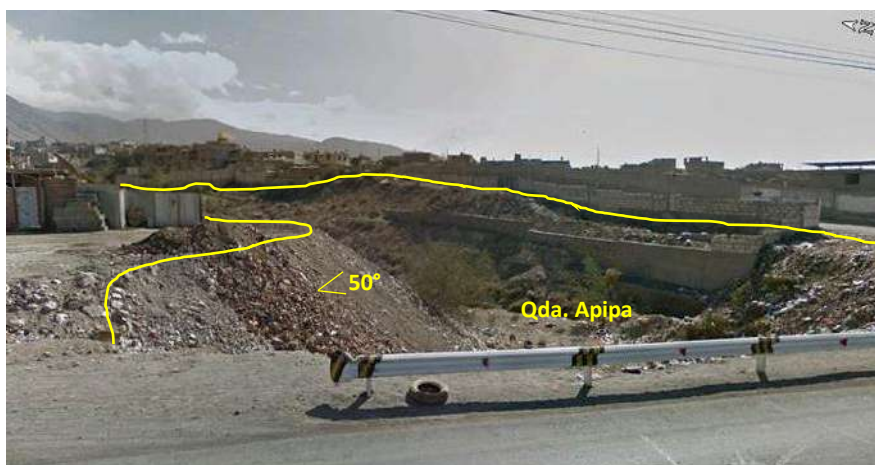
Figura 3030. Quebrada Apipa, observándose en el margen derecho muros, además la quebrada presenta pendientes fuertes a muy fuertes (~50 m) (Coordenadas UTM WGS84 222502 E, 8193528 N).
