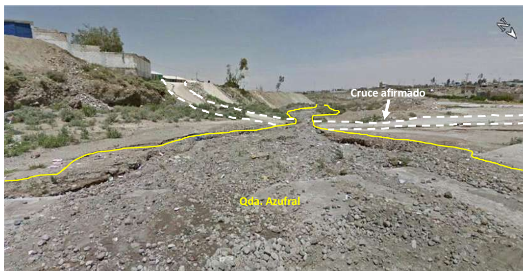
Figura 37. Cruce afirmado en el sector alto de la quebrada Azufral (Coordenadas UTM WGS84 227498 E, 8193323 N).
