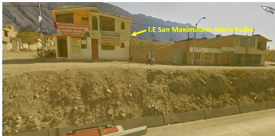
Figura 59. I.E. San Maximiliano María Kolbe, según la simulación se vería afectado por lahares con un nivel de peligrosidad moderado (Coordenadas UTM WGS84 220981 E, 8194921 N).
