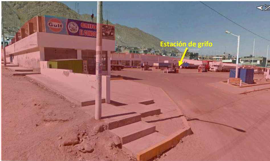
Figura 58. Estación de grifo, según la simulación se vería afectado por lahares con un nivel de peligrosidad alto (Coordenadas UTM WGS84 220859 E, 8195052 N).
