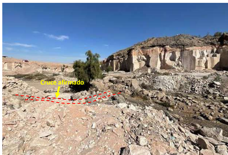
Figura 46. Cruce (punto crítico) en la Quebrada Añashuayco (Coordenadas UTM WGS84 221731 E, 8189604 N).
