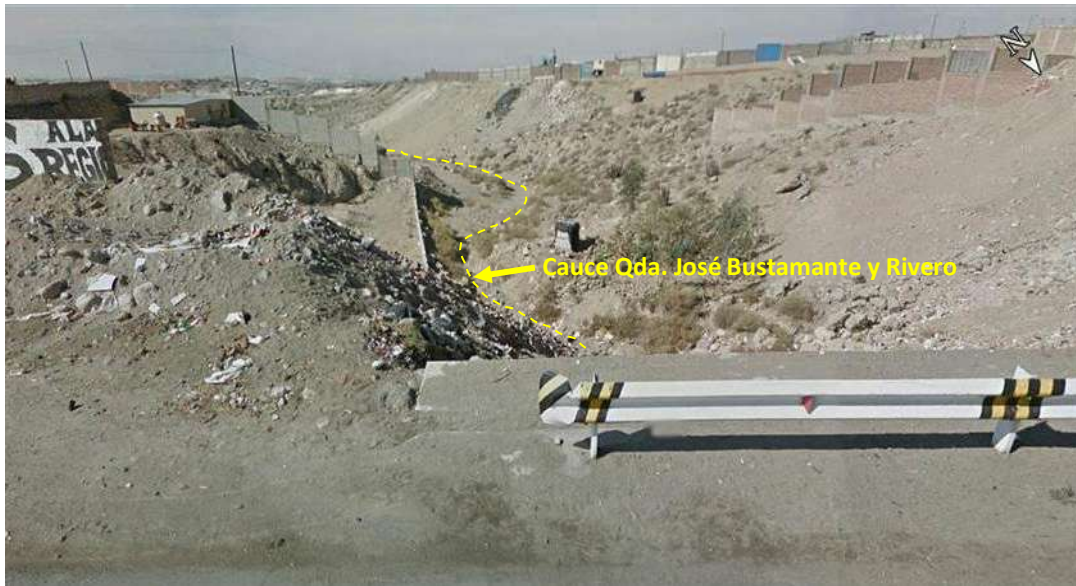
Figura 56. Punto crítico: Cruce afirmado en la quebrada José Bustamante y Rivero con muros que llegan hasta el cauce de la quebrada (Coordenadas UTM WGS84 222124 E, 8193626 N).
