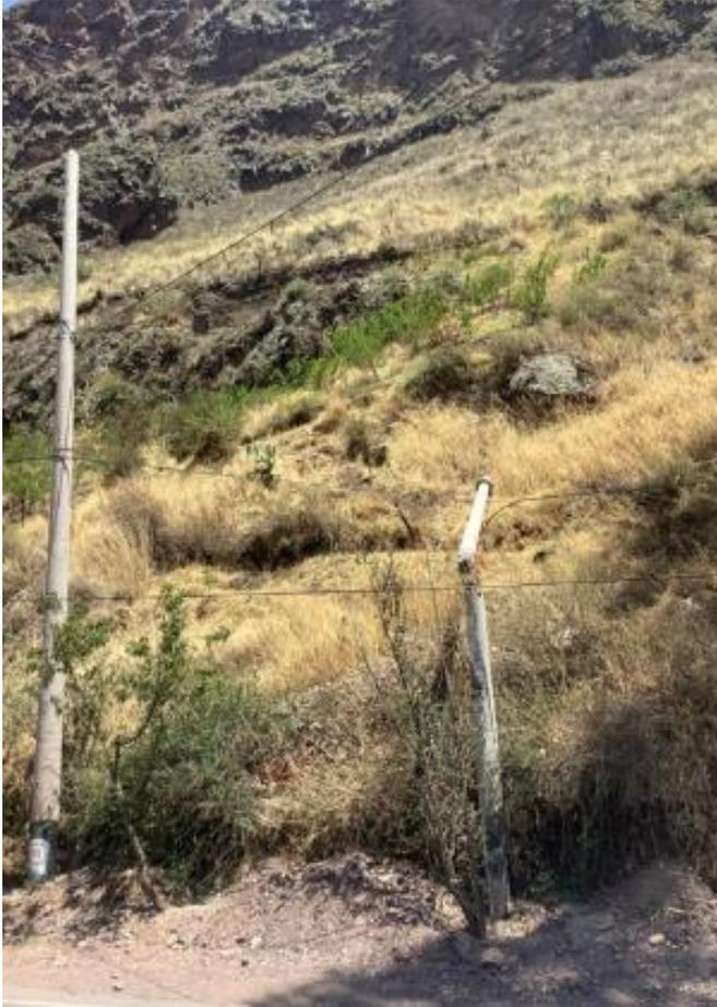
**Fotografía 6.** Postes afectados por la caída de rocas, aun son usados con el cableado eléctrico.
