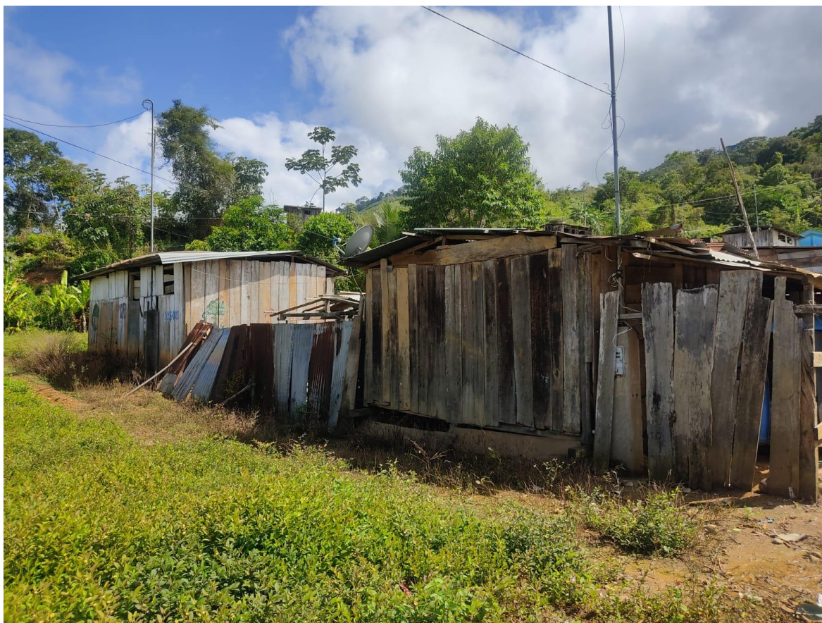
Fotografía N° 7. Vivienda con material de construcción tipo madera y calamina estos son los más predominante en paredes en la comunidad.
