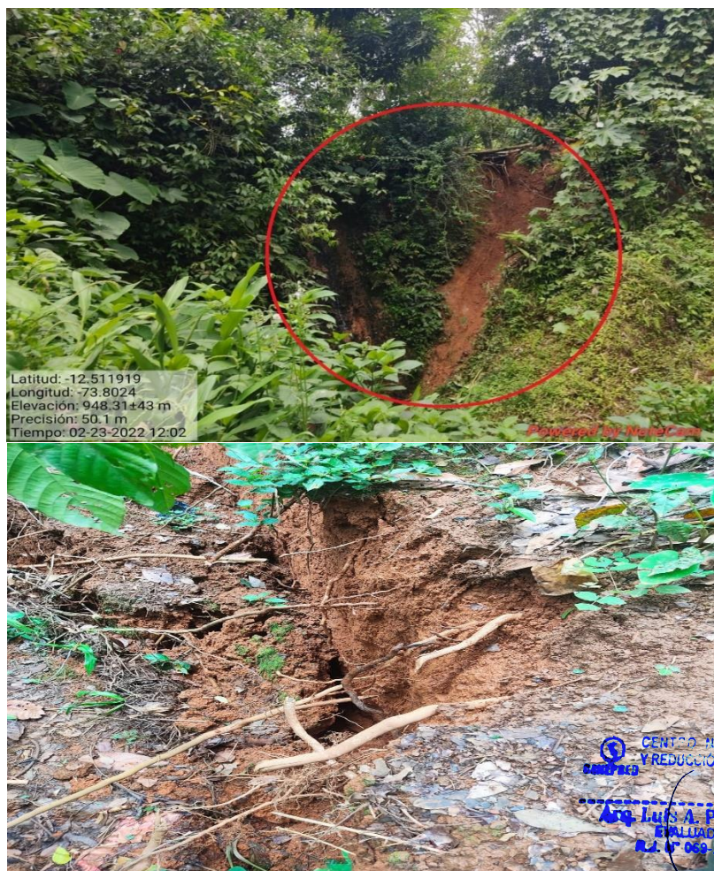
Fotografía N° 40. vista del deslizamiento ocasionado por la erosión pluvial por el mal vertimiento de las aguas usada en la comunidad.
