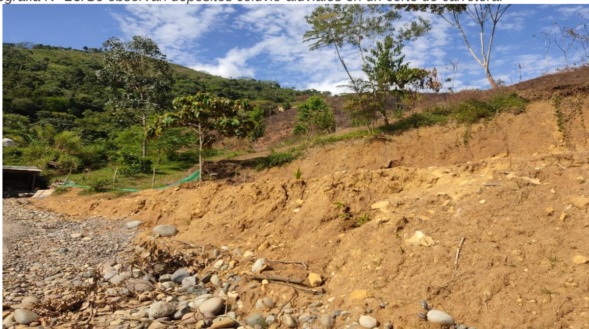
Fotografía N° 23. Se observan depósitos coluvio-aluviales en un corte de carretera.
