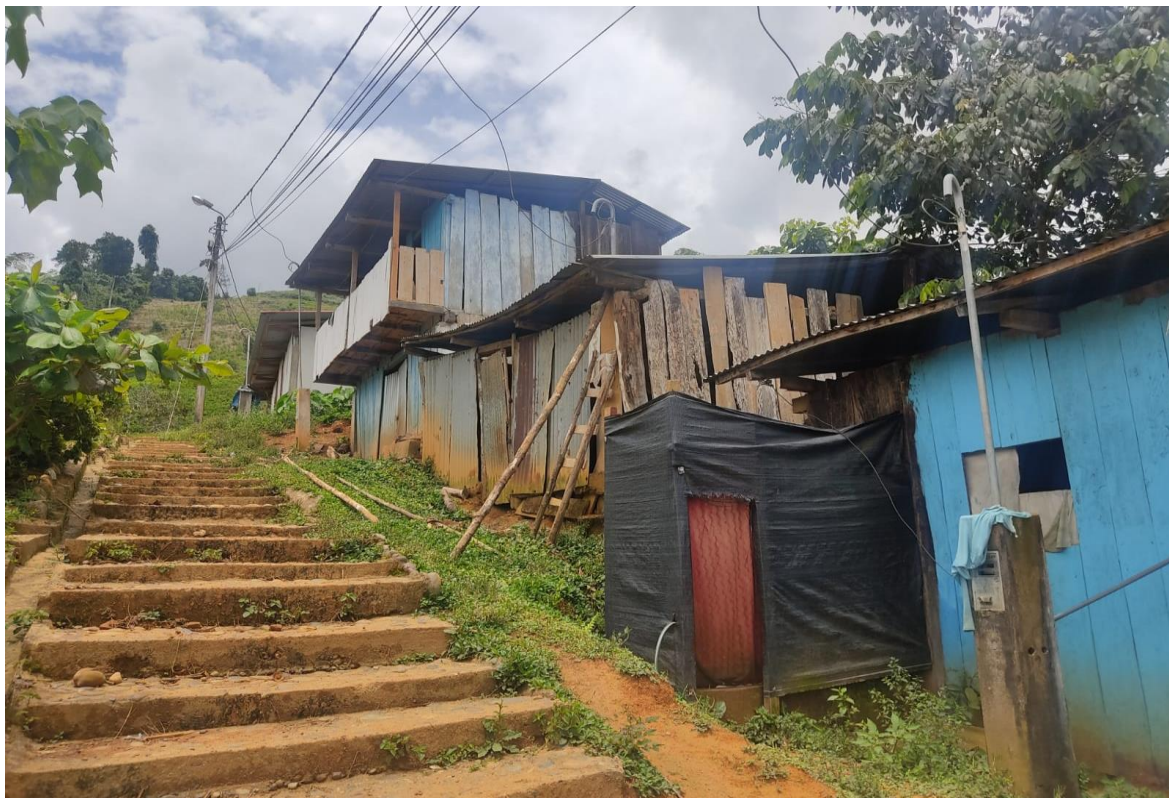
Fotografia N° 9. Se muestra viviendas existentes de 2 pisos, el material predominante es la madera utilizada para la construcción de sus viviendas.
